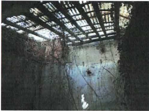
immobile vista copertura e locale interno
