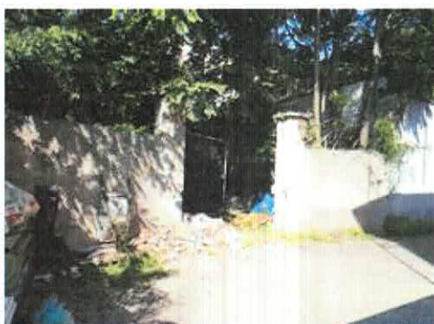
Vista cancello ingresso viale Catania 4
