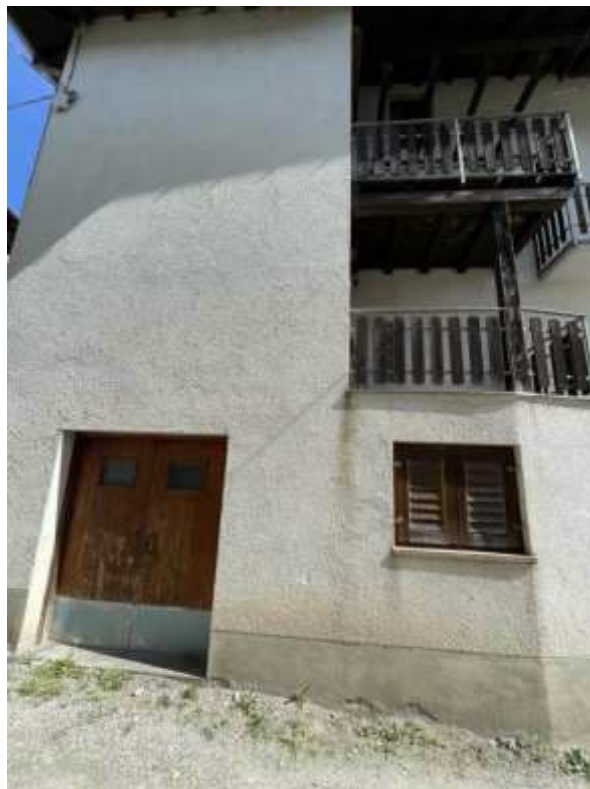
Ingresso lato Ovest
