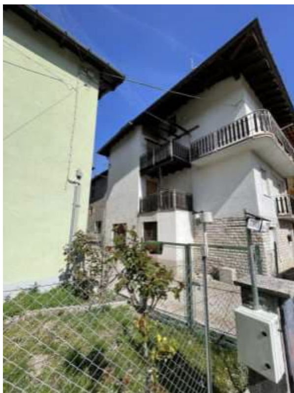
Lato Sud Ovest
