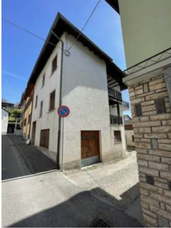
Lato Nord Ovest
