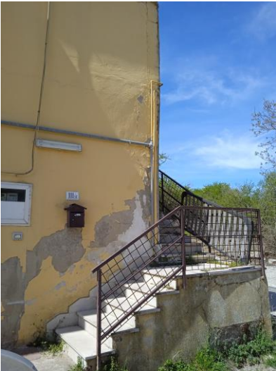
Scala di accesso
