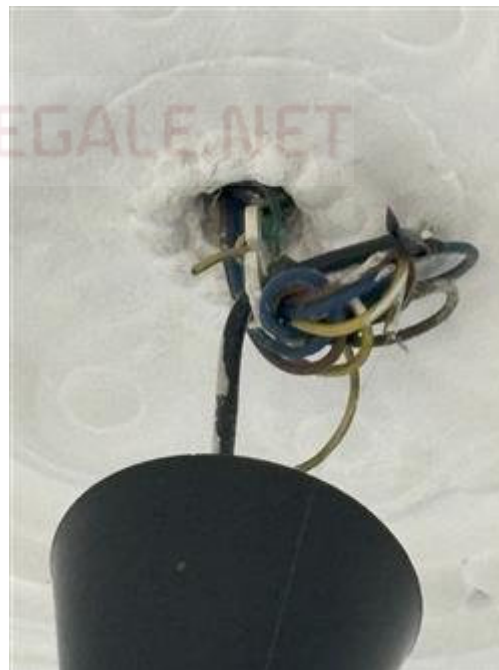
Dettaglio punto luce (centro volta) della camera a sinistra dell'ingresso.
