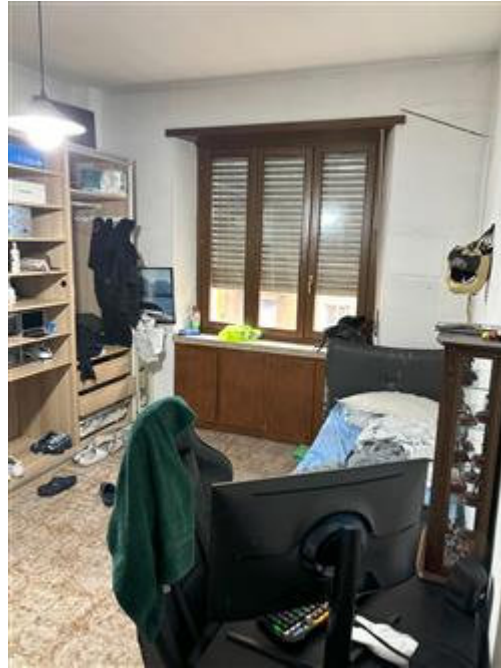
Stato degli infissi esterni. Infisso camera a sinistra dell'ingresso.
