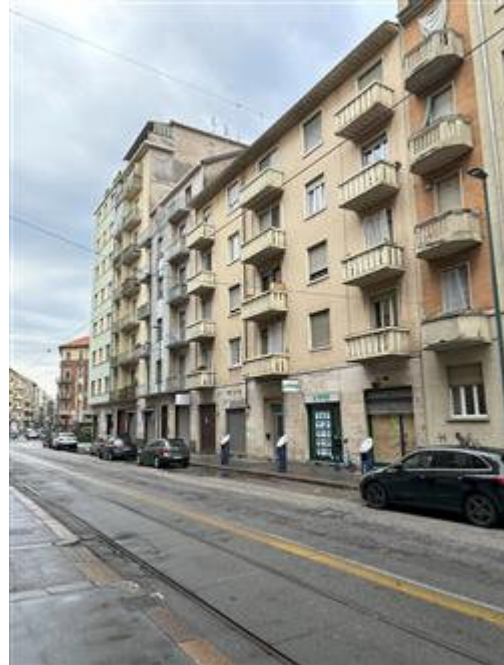
Prospetto della via Chiesa della Salute con presenza di attività commerciali locali
