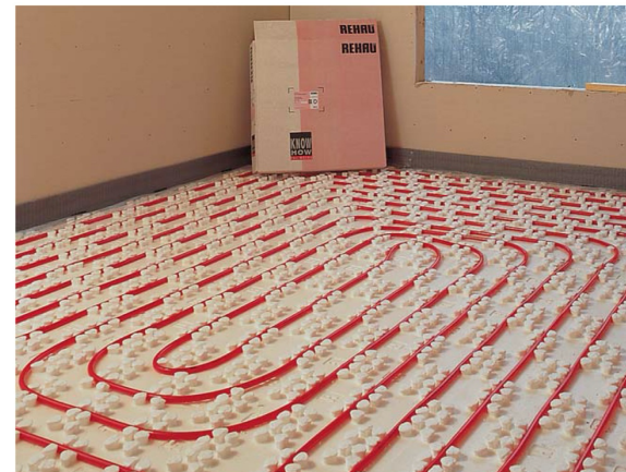
Fig. 2-11: Sistema REHAU pannello sagomato Vario
