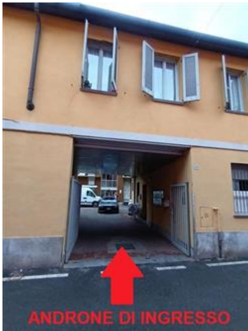
ingresso dalla strada tramite androne comune
