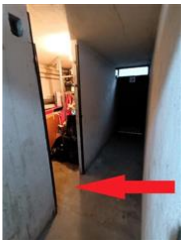
situazione rilevata della cantina
