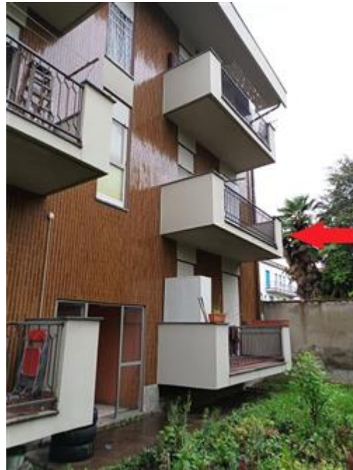
facciata a lato nord
