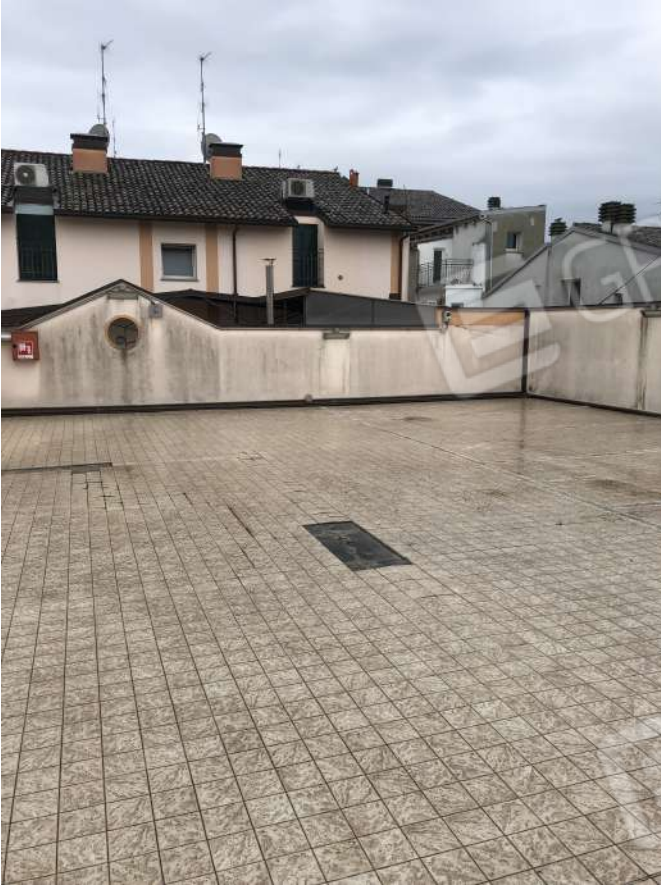
Foto 11- Piano 2° spazio di manovra
