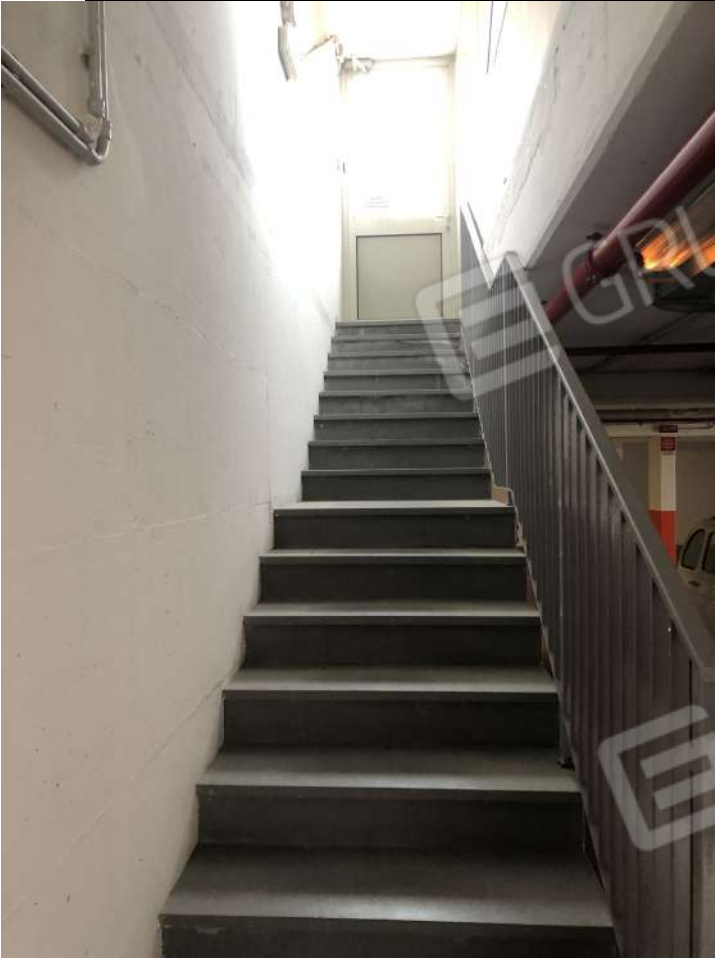
Foto 7- scala interna di collegamento al 2° piano
