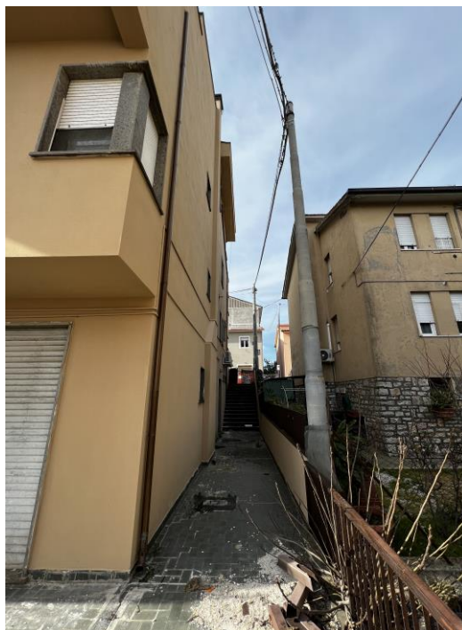
FOTO PARTICOLARE CORRIDOIO INTERNO ACCESSO U.I.U.
