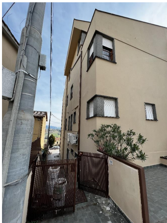
FOTO PARTICOLARE SU ACCESSO ESTERNO (DA VIA ROMA N. 59)
