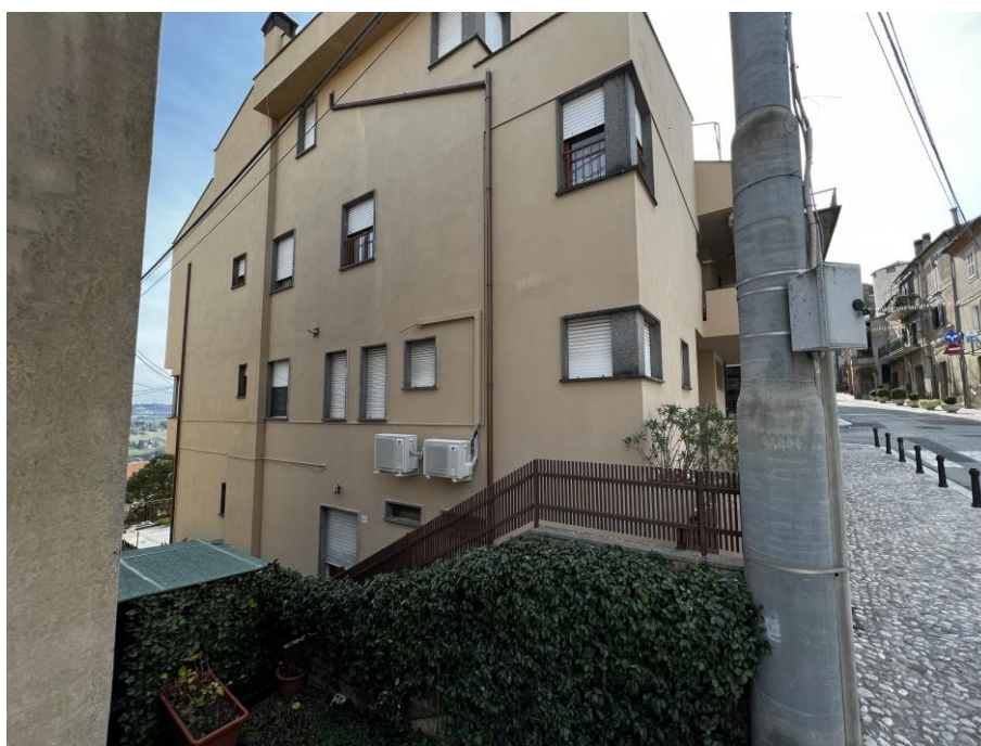
FOTO PROSPETTO LATERALE SU SCALA ESTERNA DI ACCESSO (DA VIA ROMA N. 59)
