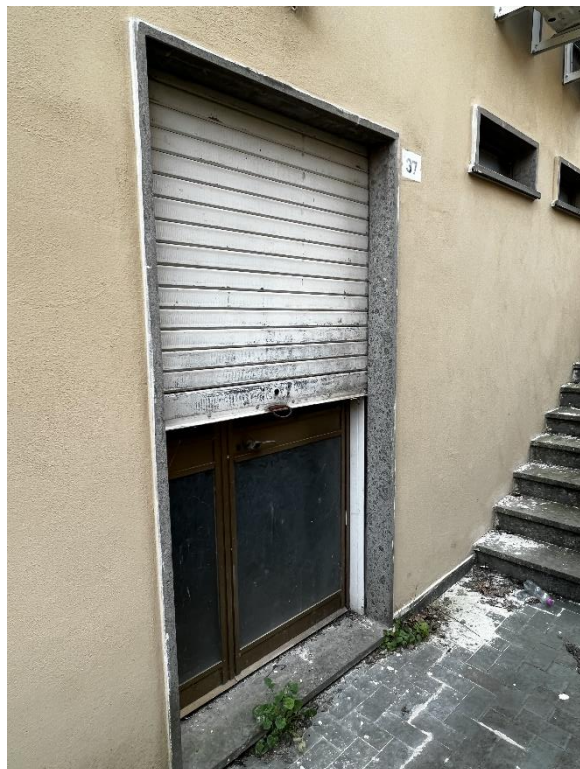
FOTO PARTICOLARE ACCESSO U.I.U. DA INGRESSO INTERNO (2)
