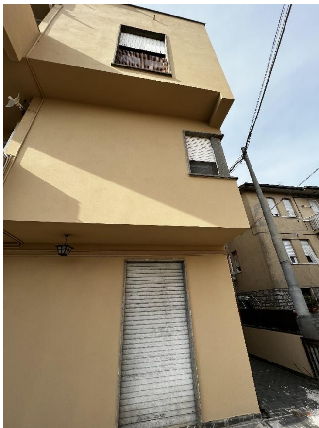
FOTO PARTICOLARE PROSPETTO RETROSTANTE DEL FABBRICATO
