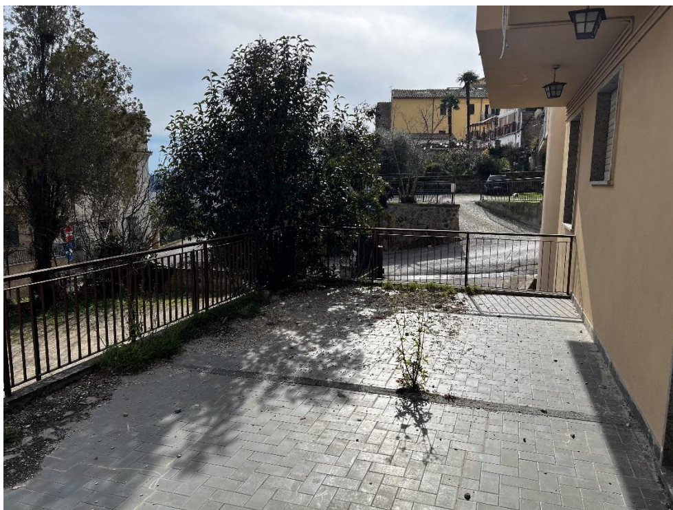
FOTO PARTICOLARE TERRAZZO DELL' U.I.U.
