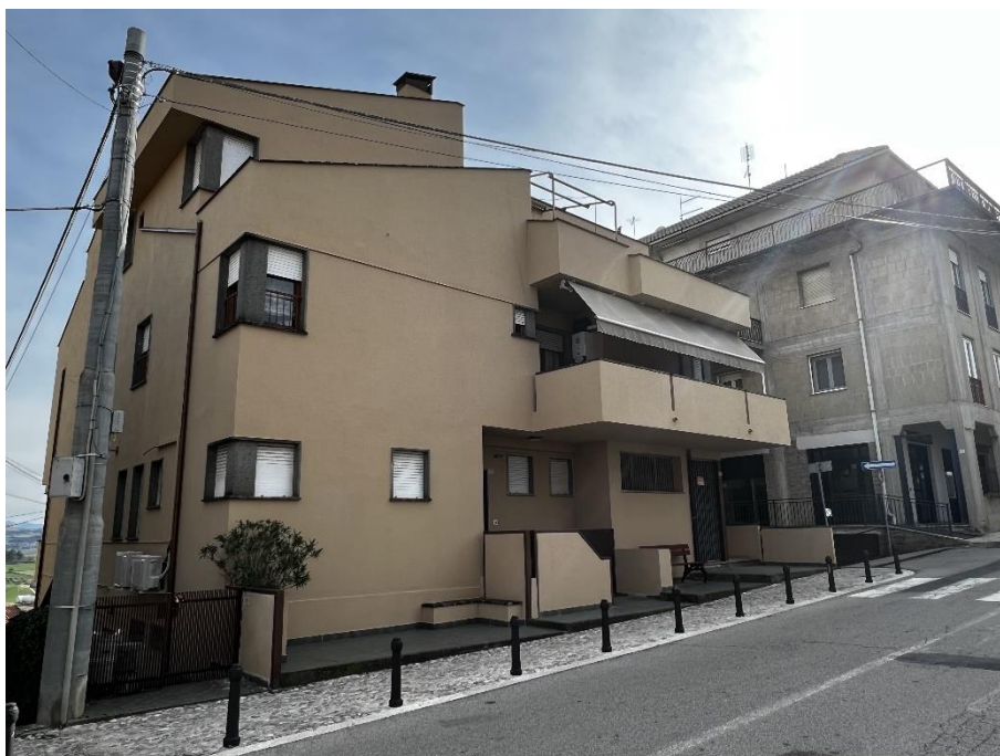
FOTO PROSPETTO FRONTALE SU ACCESSO ESTERNO (DA VIA ROMA N. 59)
