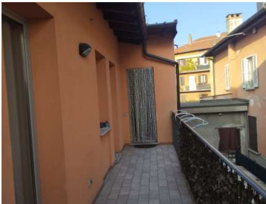
BALCONE A PIANO PRIMO
