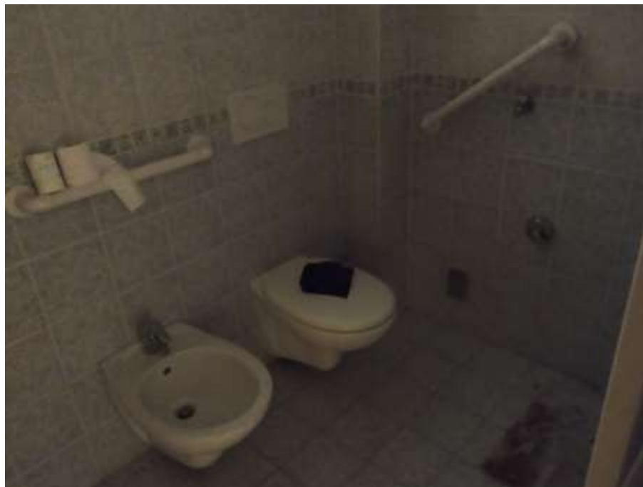
BAGNO CON AREAIZIONE DAL CAVEDIO
