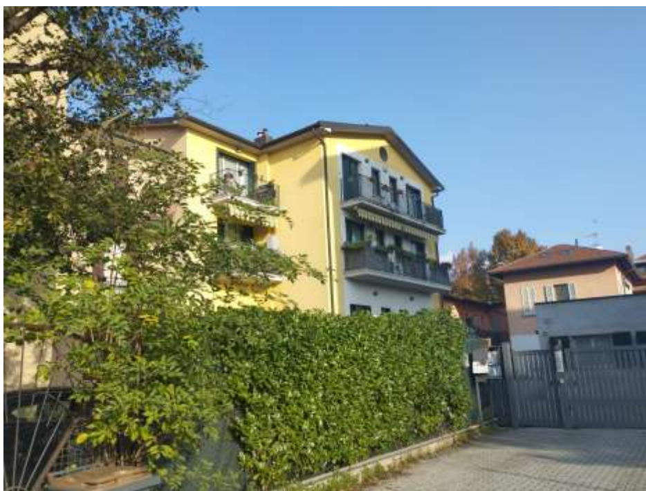
VISTA DEL COMPLESSO DA VIA TONALE
