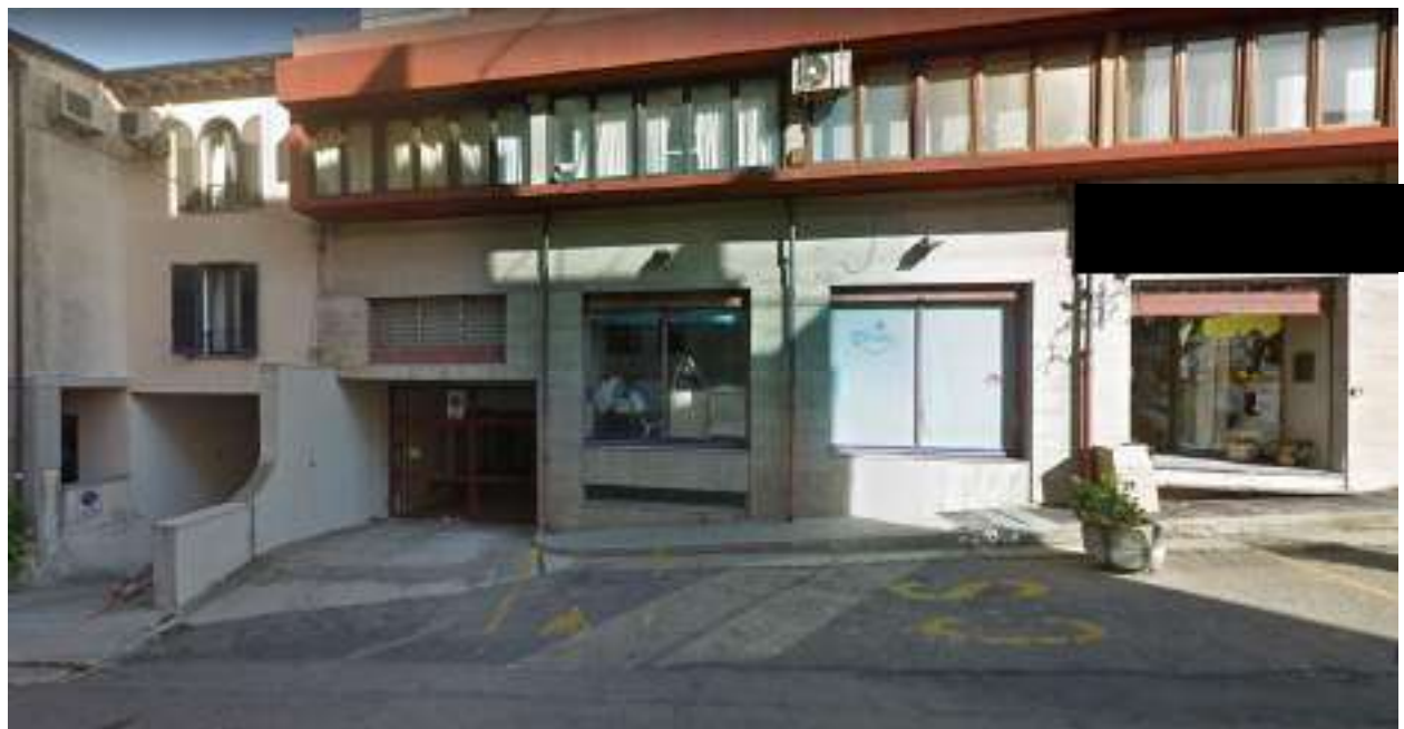
Foto 2 – Prospetto su via Marconi
