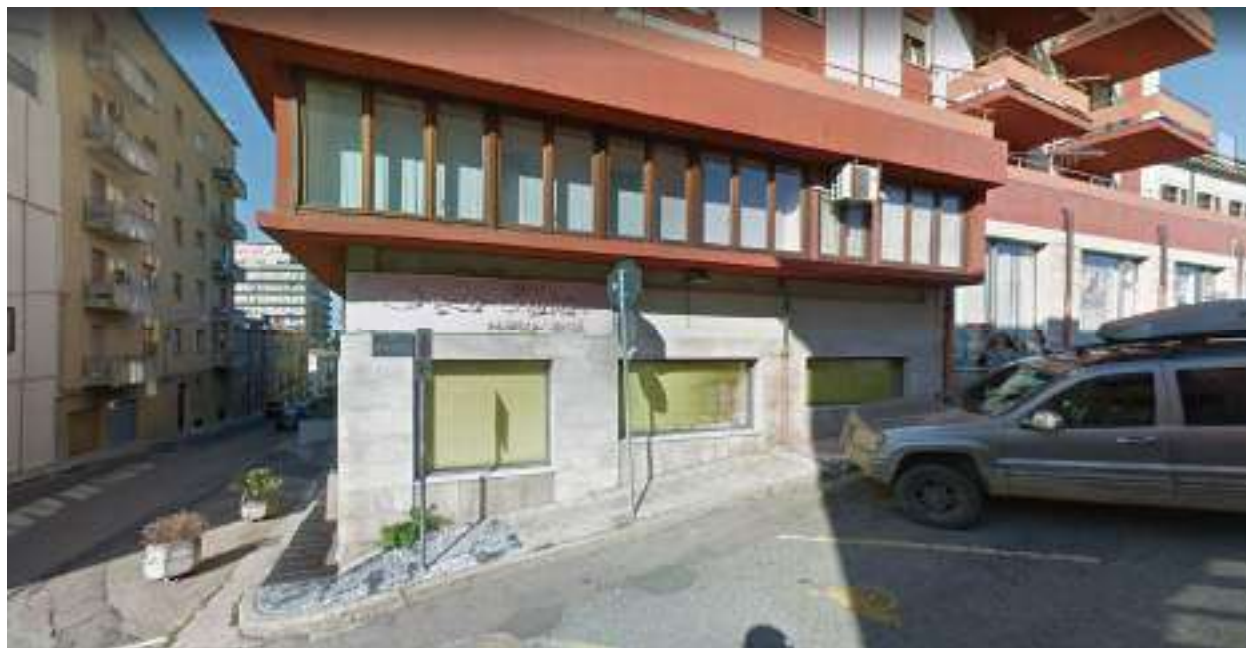
Foto 3 – Prospetto su via Episcopo
