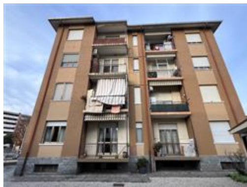
Fronte su cortile interno
