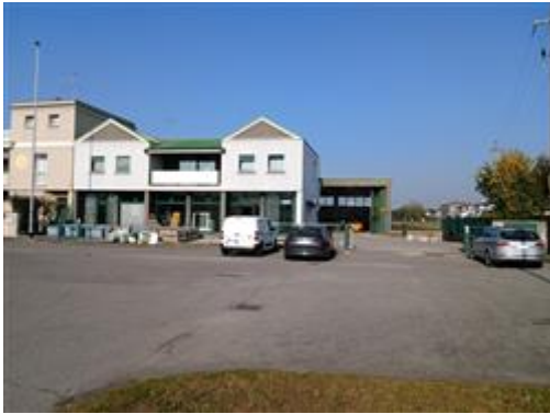
Vista d'insieme del fabbricato da via Libero Grassi
