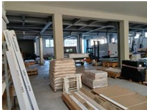
Particolare zona magazzino/deposito al piano interrato (sub. 1)
