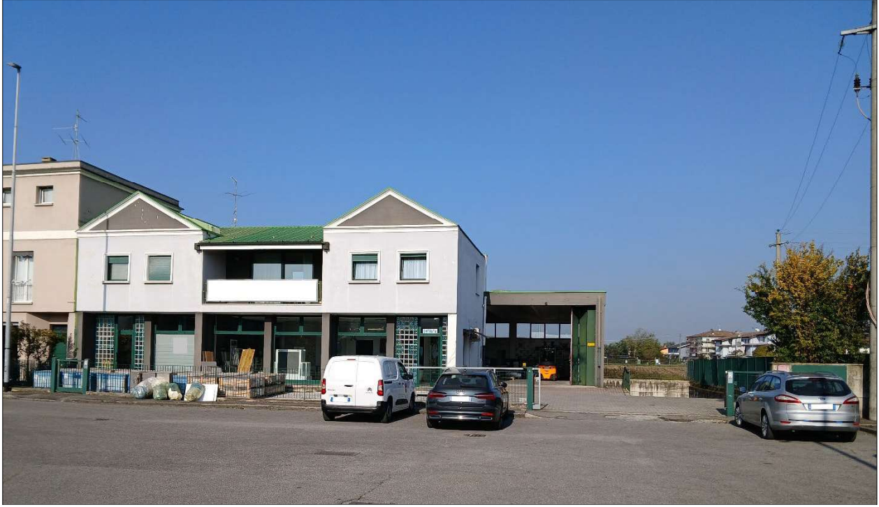
Foto n. 1 – Vista d'insieme del fabbricato da via Libero Grassi
