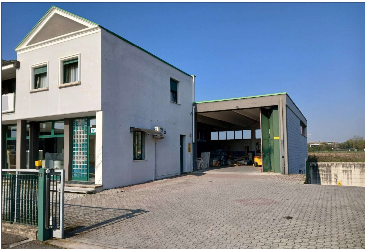
Foto n. 4 – Vista prospettica con ingresso carrabile da via Libero Grassi e area di pertinenza esterna
