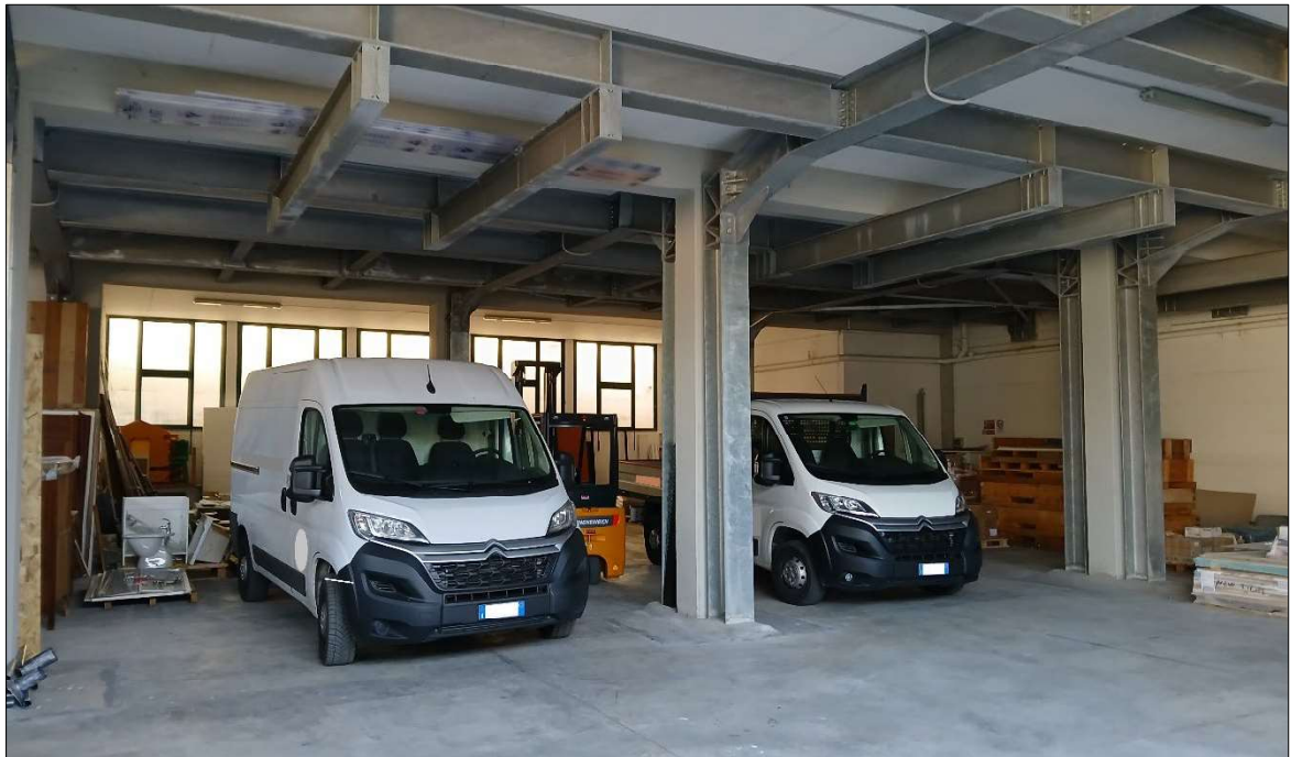
Foto n. 20 – Particolare p. interrato (sub.1) magazzino/deposito
