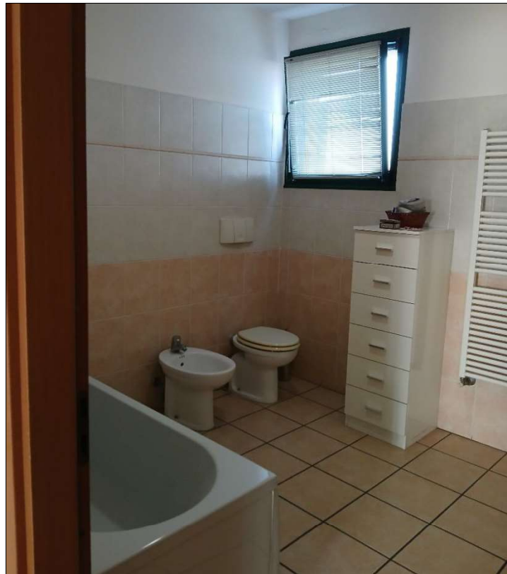
Foto n. 34 – Particolare p.1° (sub.2) Abitazione – Bagno
