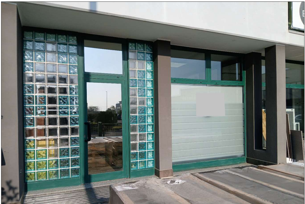
Foto n. 6 – Particolare ingresso a p.t. vano scala e area espositiva/commerciale
