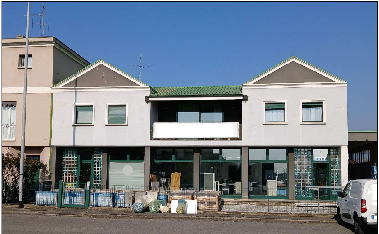
Foto n. 2 – Prospetto del fabbricato su via Libero Grassi
