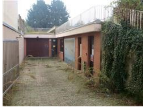
La rampa carrabile ed il cortile
