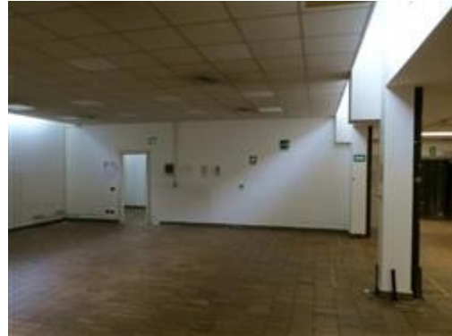
La porzione più alta controsoffittata
