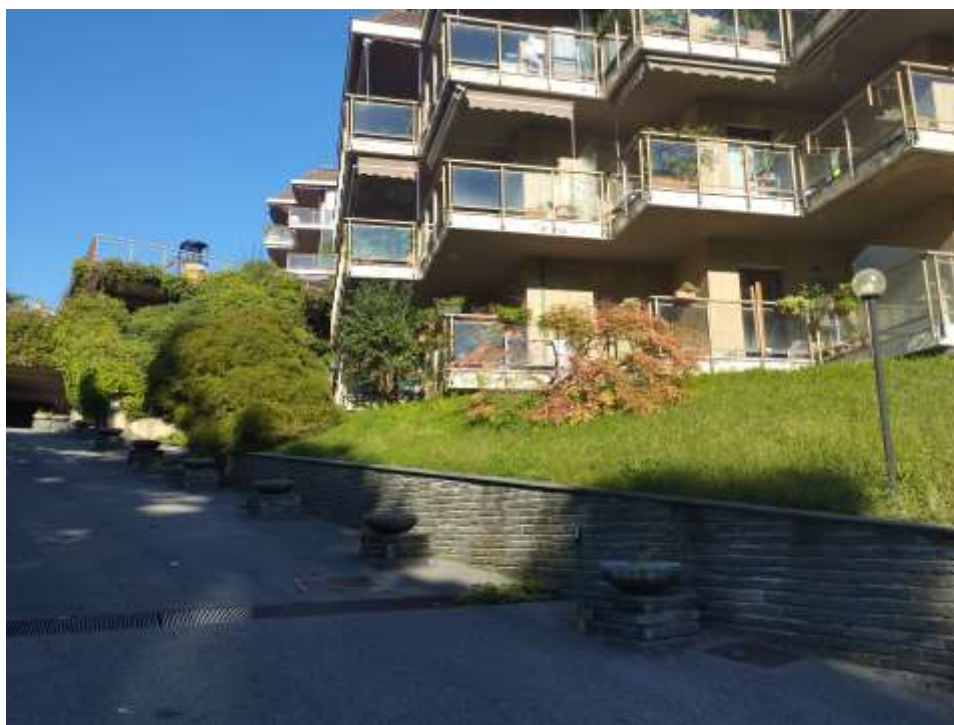
VISTA DALL'ACCESSO CARRAIO
