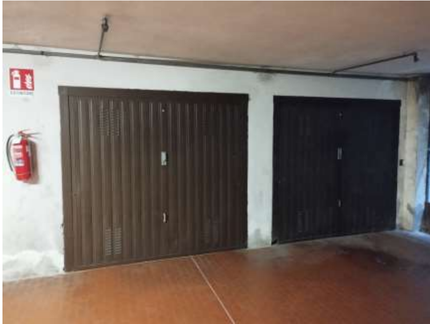
VISTA AUTORIMESSA DAL CORSELLO DI MANOVRA
