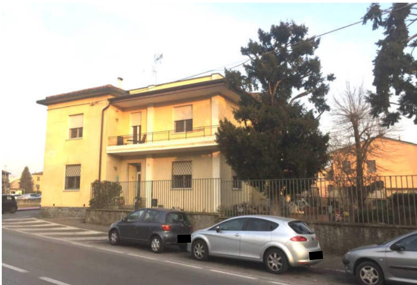
Prospetto Ovest dell'abitazione in oggetto, da via Brescia
