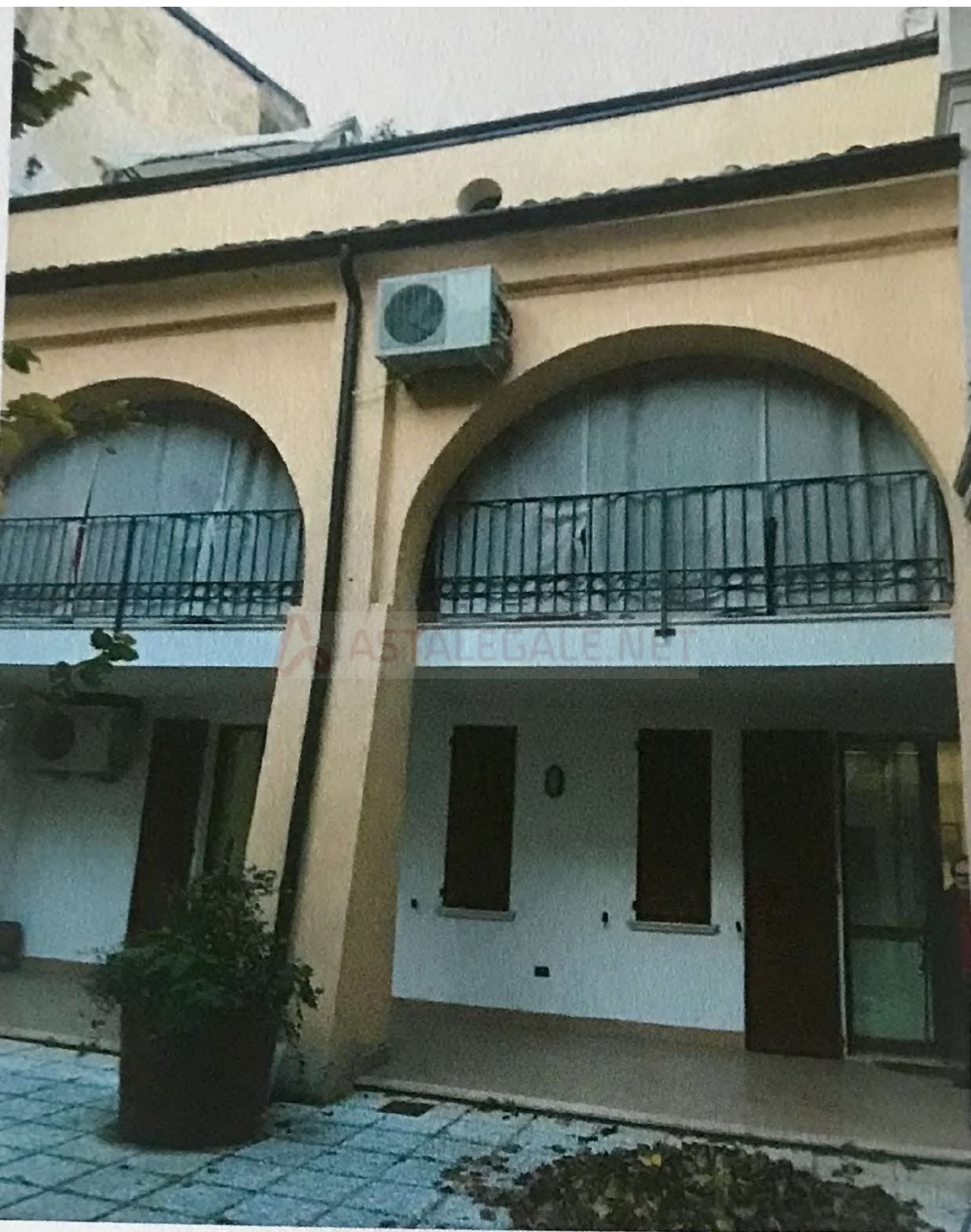
Vista esterna dal cortile interno
