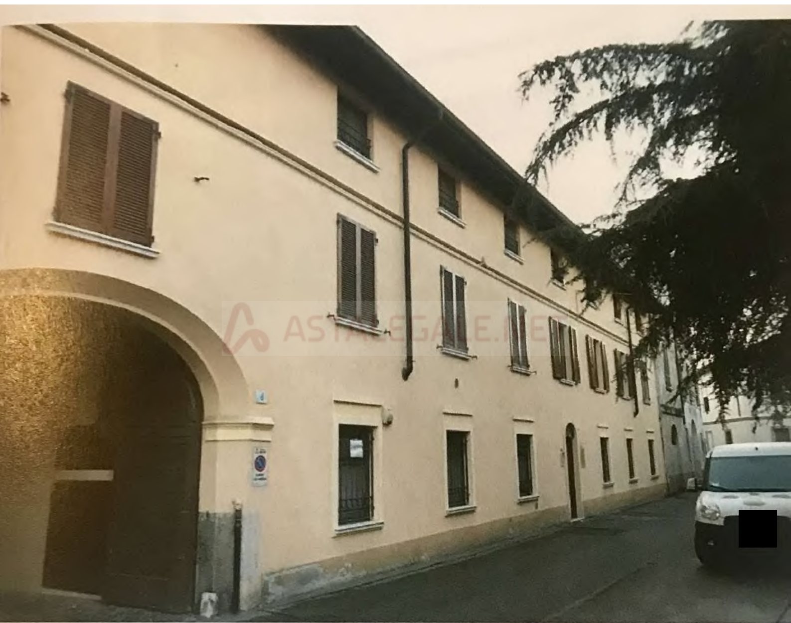
Vista esterna da via Bertesi del fabbricato condominiale
