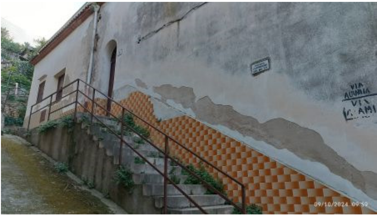
Prospetto su via Alamia
