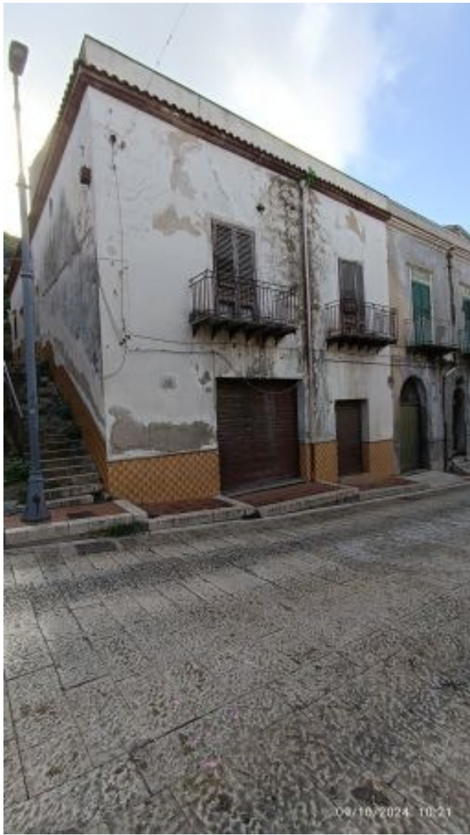
Prospetto su Via Roma
