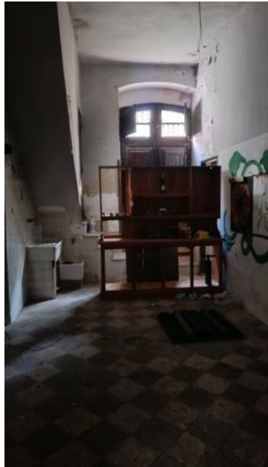
Cucina (a sinistra la scala verso il sottotetto)
