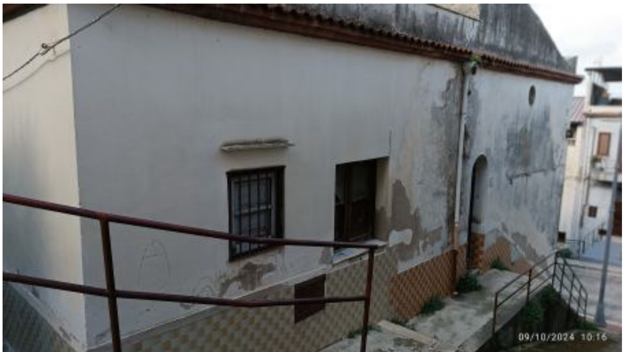
Prospetto su via Alamia
