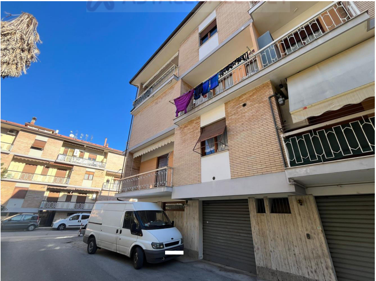
Esterno lato ovest
