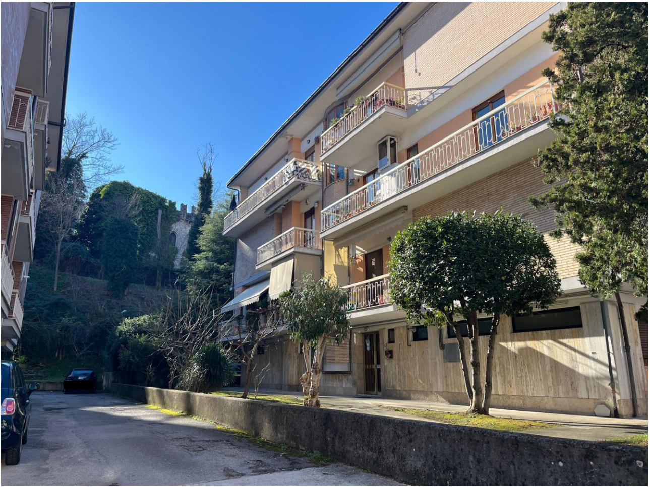
Esterno lato est
