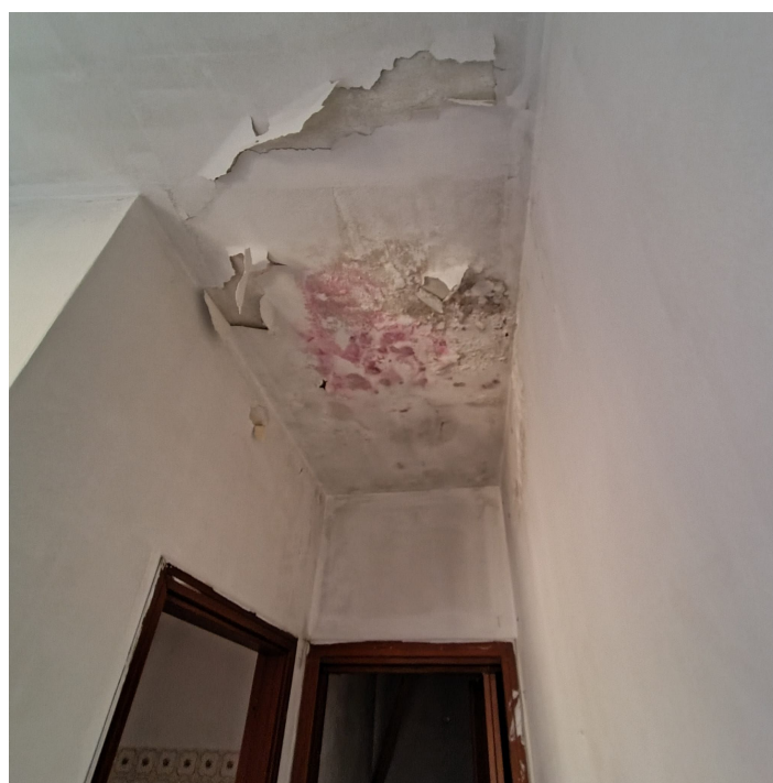
DISIMPEGNO PIANO PRIMO
