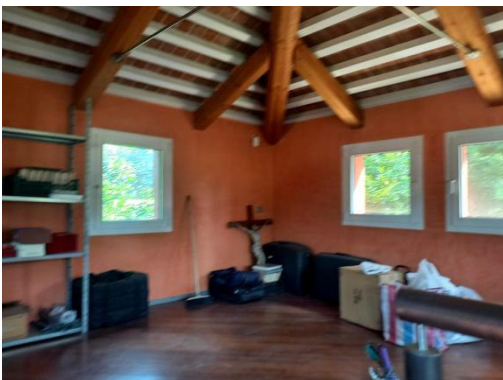
VANO IN TORRE EST LOTTO 2
