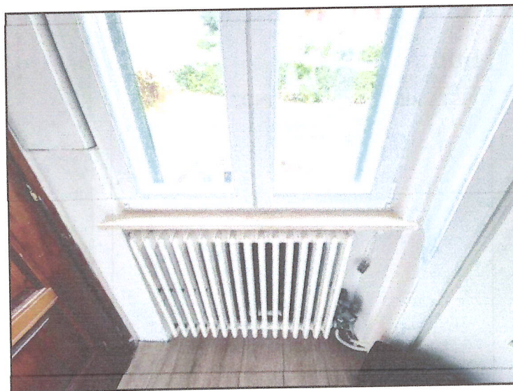
FOTO 12 U.I. MAPP. 4384 SUB. 502 VISTA PARTICOLARE RIPRESA VERSO FINESTRA DEL DISIMPEGNO.
