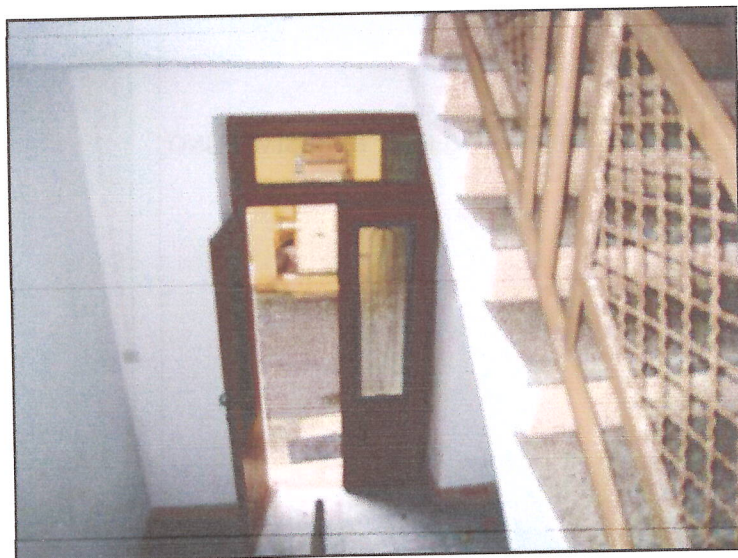
FOTO 6 ALTRA VISTA RIPRESA VERSO L'INGRESSO VANO SCALE COMUNE.
