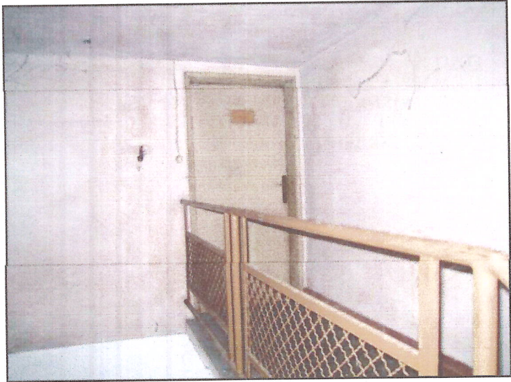
FOTO 32 VISTA DAL VANO SCALA COMUNE VERSO INGRESSO AL SOTTOTETTO.
