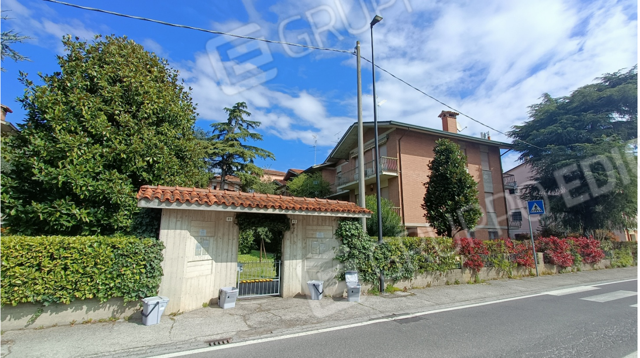
Vista esterna del fabbricato da via Vicoli
