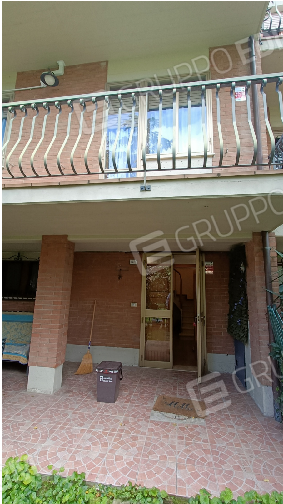
Vista esterna dell'ingresso
