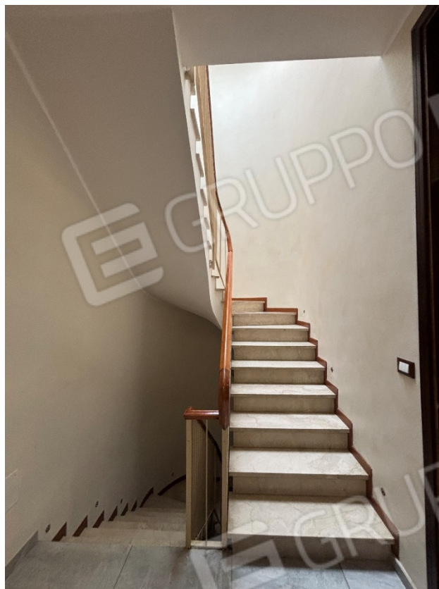
Vista scale di accesso al piano secondo
