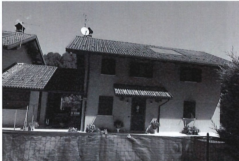
Vista fabbricato da sud
