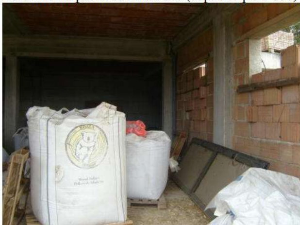
Foto interna piano seminterrato (deposito part. 880)
