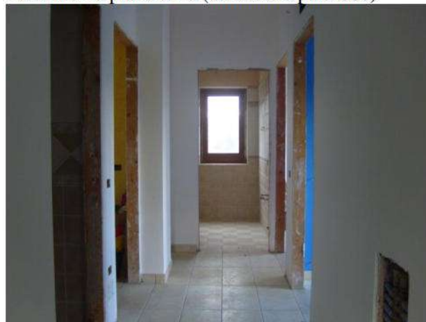
Foto interna piano terra (abitazione part. 880)
