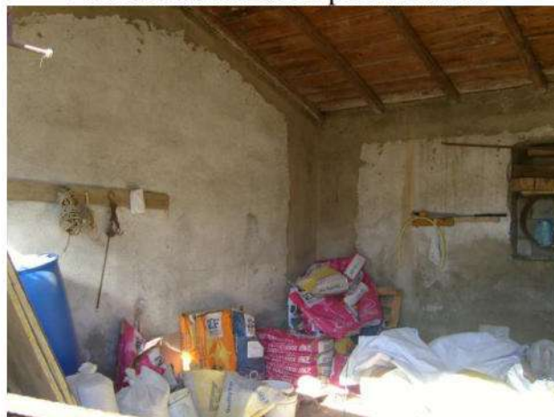
Foto interna immobile part.IIa n. 748
