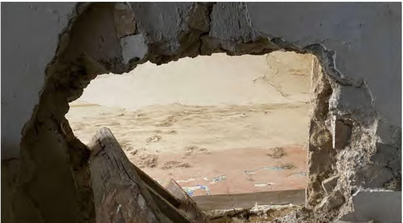
Porzione di solaio crollato, da cui si accede al Piano Primo (tramite scala in legno)
