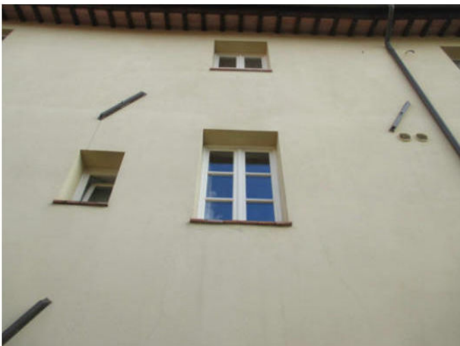
Facciata esterna (9).JPG
