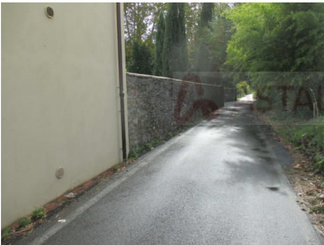
Facciata esterna (11).JPG
