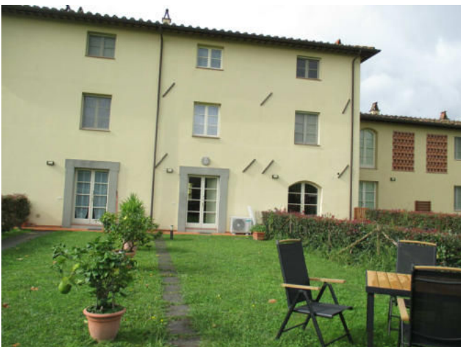
Facciata esterna (3).JPG
