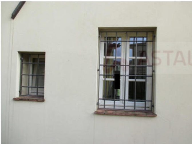
Facciata esterna (7).JPG
