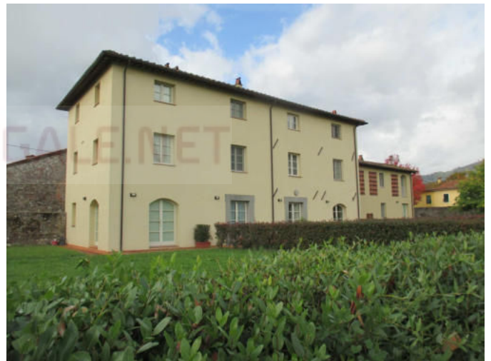
Facciata esterna (2).JPG
