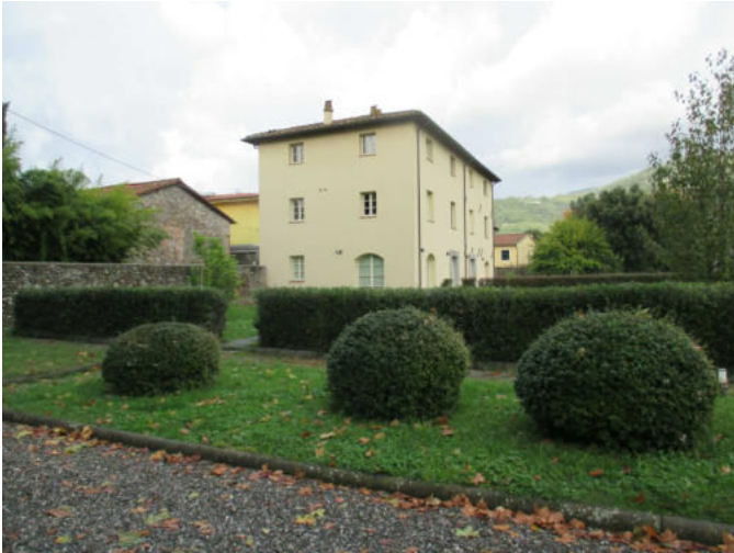
Facciata esterna (1).JPG
