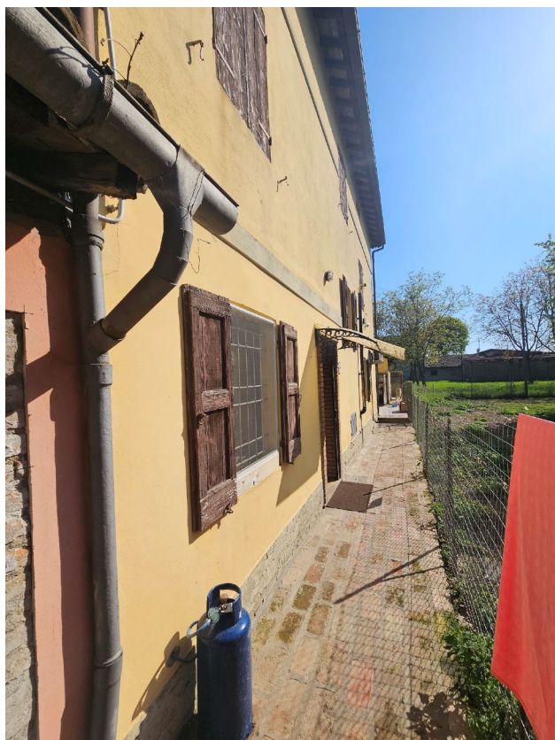
Esterno 4: Fabbricato abitativo map.84 – prospetto ovest
