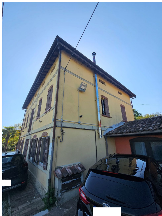
Esterno 5: Fabbricato abitativo map.84 – prospetto nord/est
