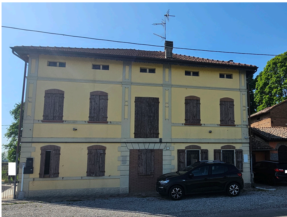
Esterno 2: Fabbricato abitativo map.84 – prospetto est
