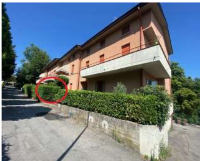
Vista Esterna n.2
