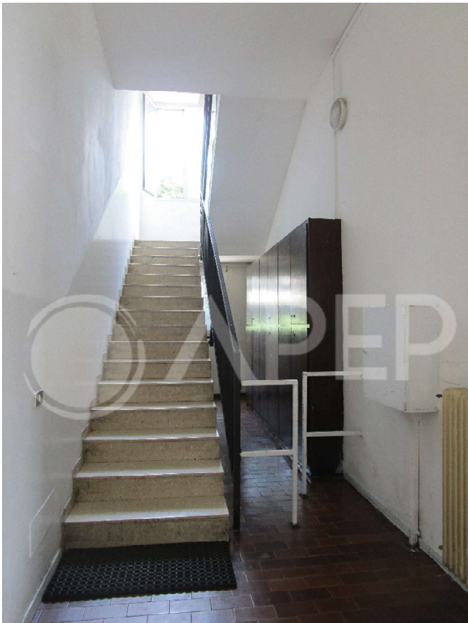
Foto 3 e 4 – Vista del vano scala comune
