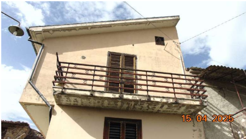
Particolare balcone e infisso esterno (soggiorno/pranzo)
