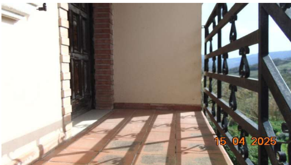
Particolare pavimento ballatoio ingresso (soggiorno/pranzo)
