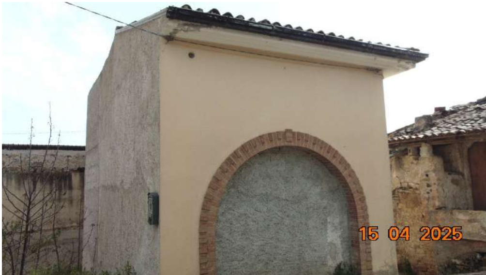
Prospetto su strada pubblica
