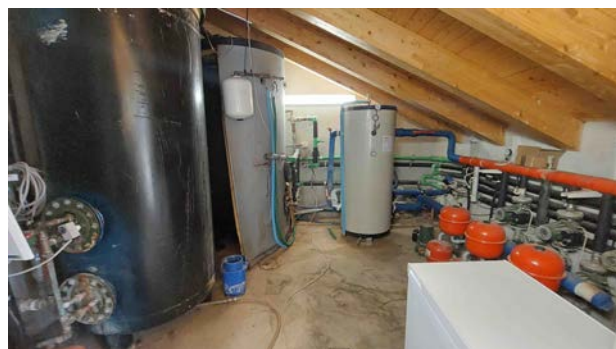
LOCALE TECNICO - PIANO SOTTOTETTO
