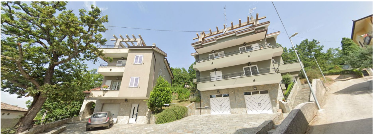
Vista frontale — scala esterna, verde e contesto panoramico
