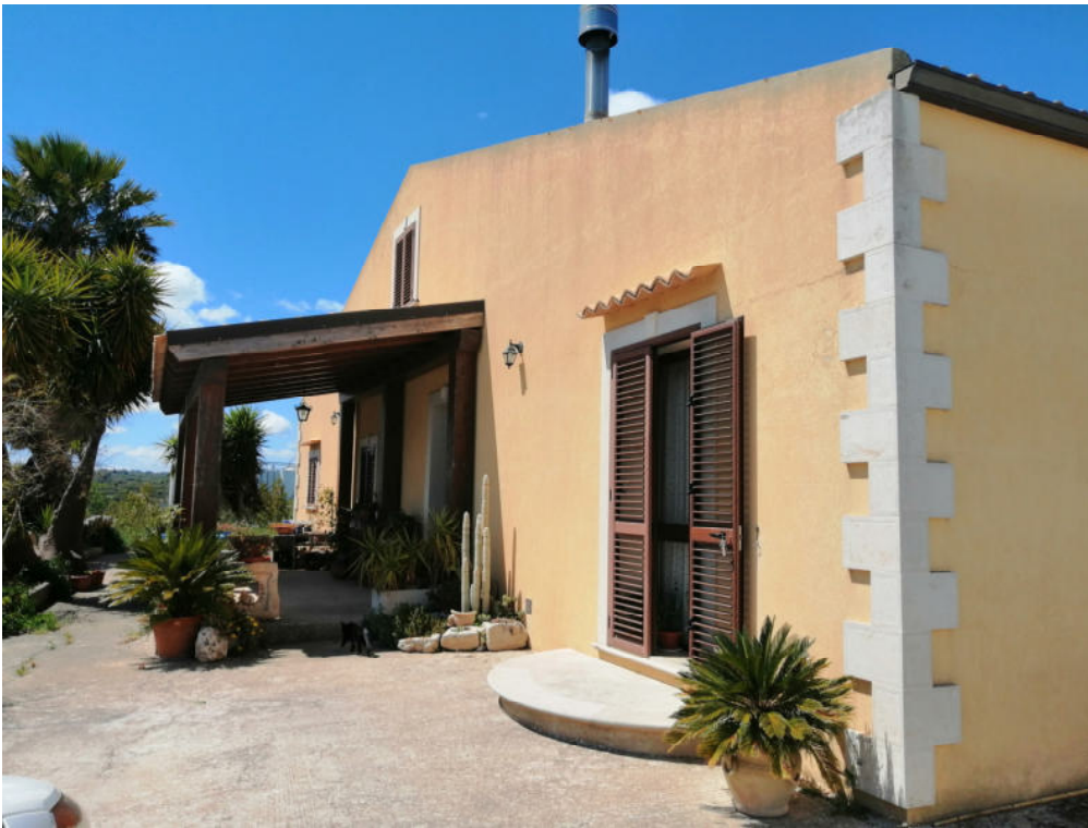
FOTO N.1 – PROSPETTO ESTERNO SU VIA DEL TELLESIMO (LATO EST)
