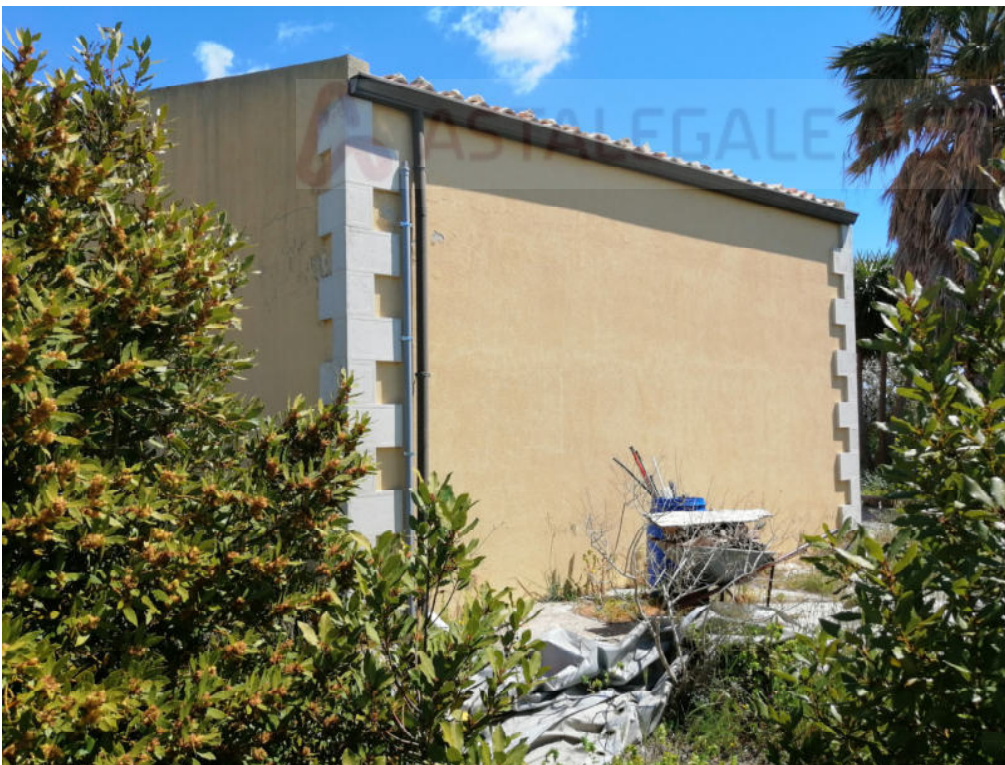
FOTO N.4 – PROSPETTO LATO SUD
