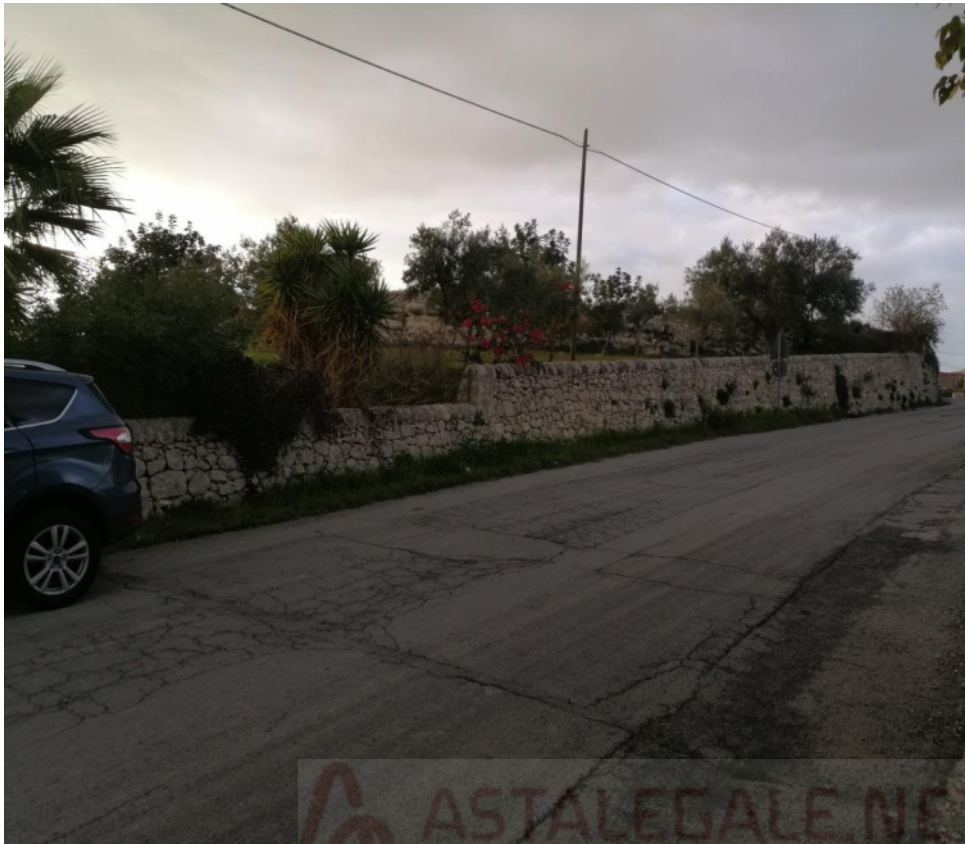
Foto n.1 - Vista particella n.332 sul lato a confine con la strada
