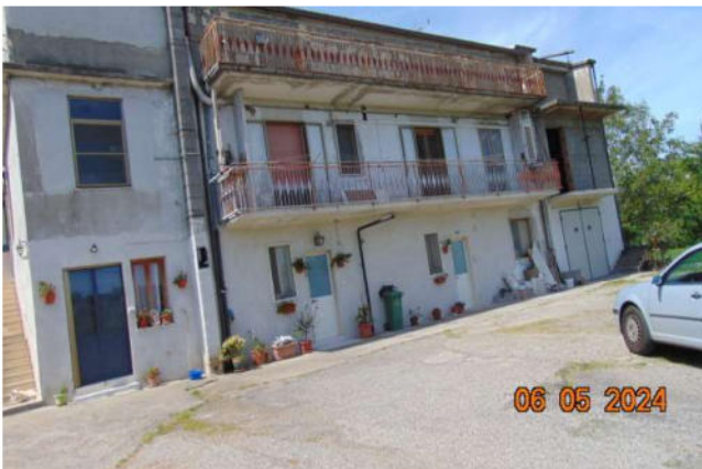
Prospetto principale e piazzale
