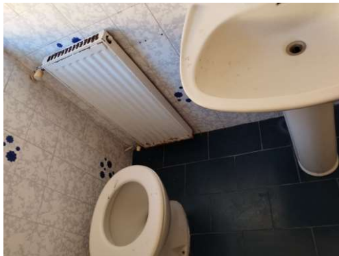
9) bagno Piano Primo
