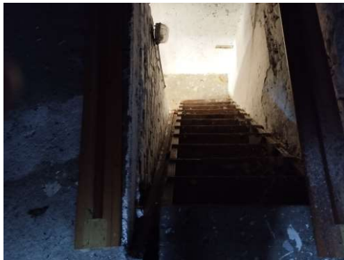
10) scala di accesso al sottotetto
