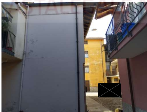
4) vista immobile lato cieco
