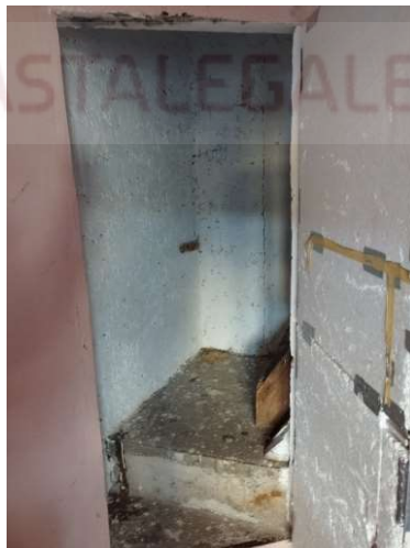
9) accesso al sottotetto
