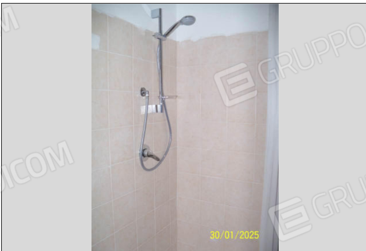
Vista Interna: Angolo doccia all'interno del bagno
