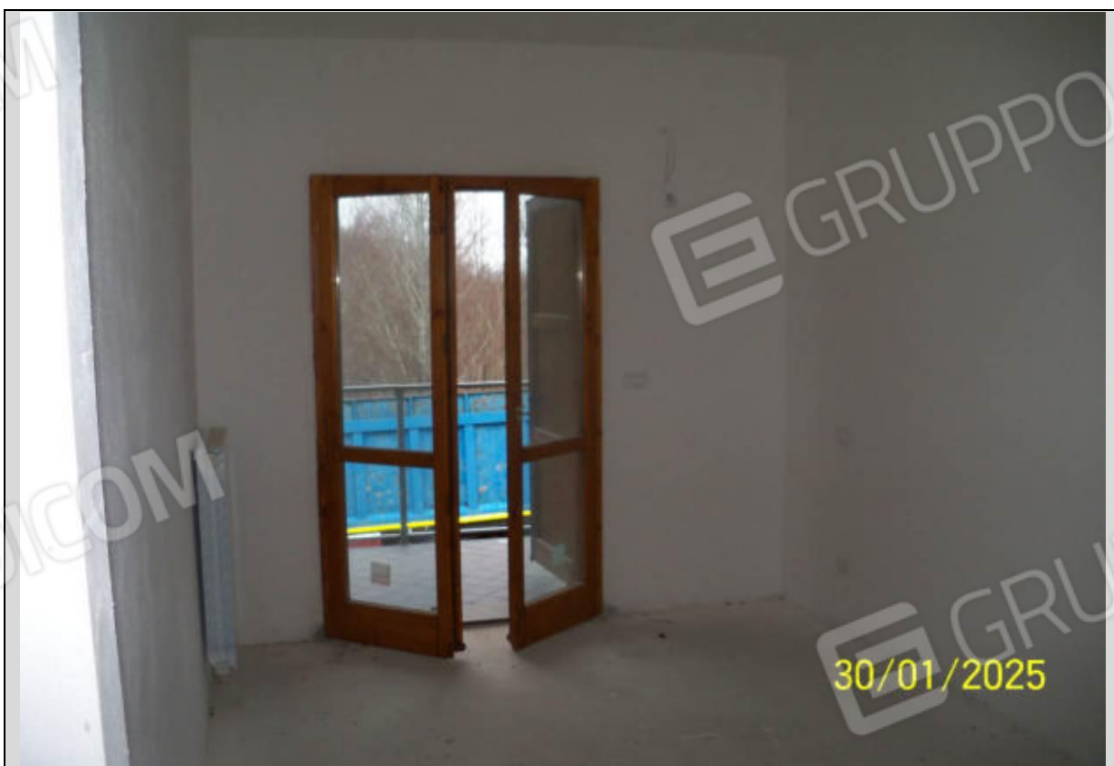
Vista Interna: Camera con accesso al balcone esclusivo
