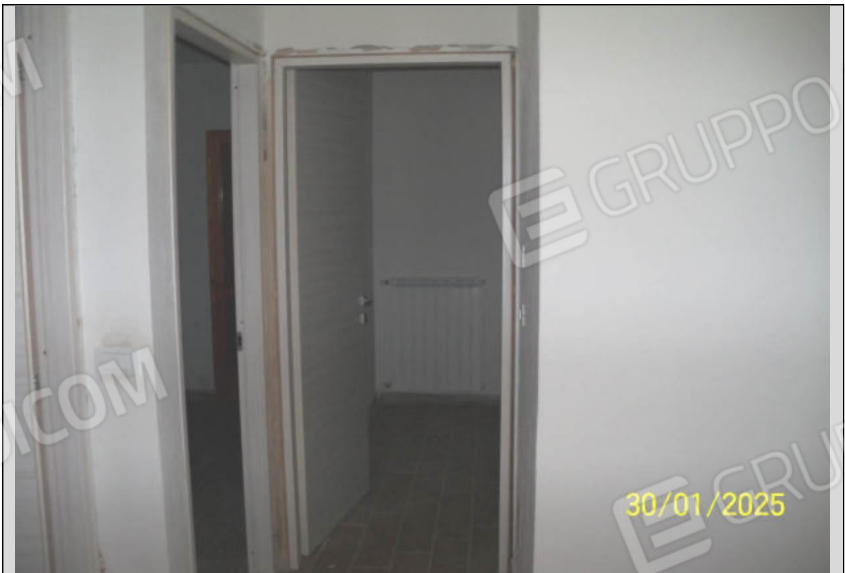
Vista Interna: Zona disimpegno vista dal locale ingresso-soggiorno Si nota l'assenza delle "ciambrane" delle porte interne
