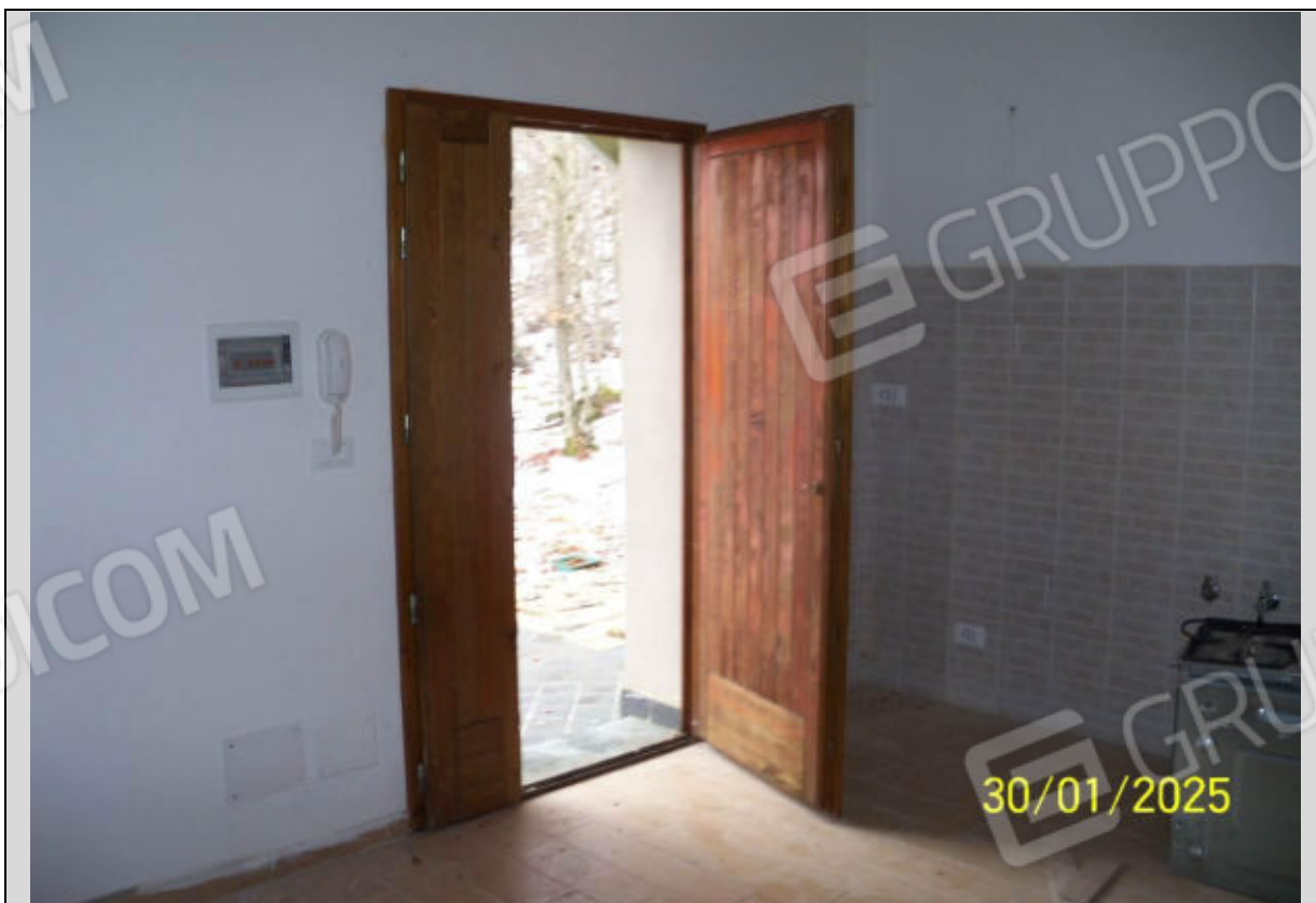
Vista Interna: Locale cottura - soggiorno dell'abitazione posta al piano terra di cui al sub.32
