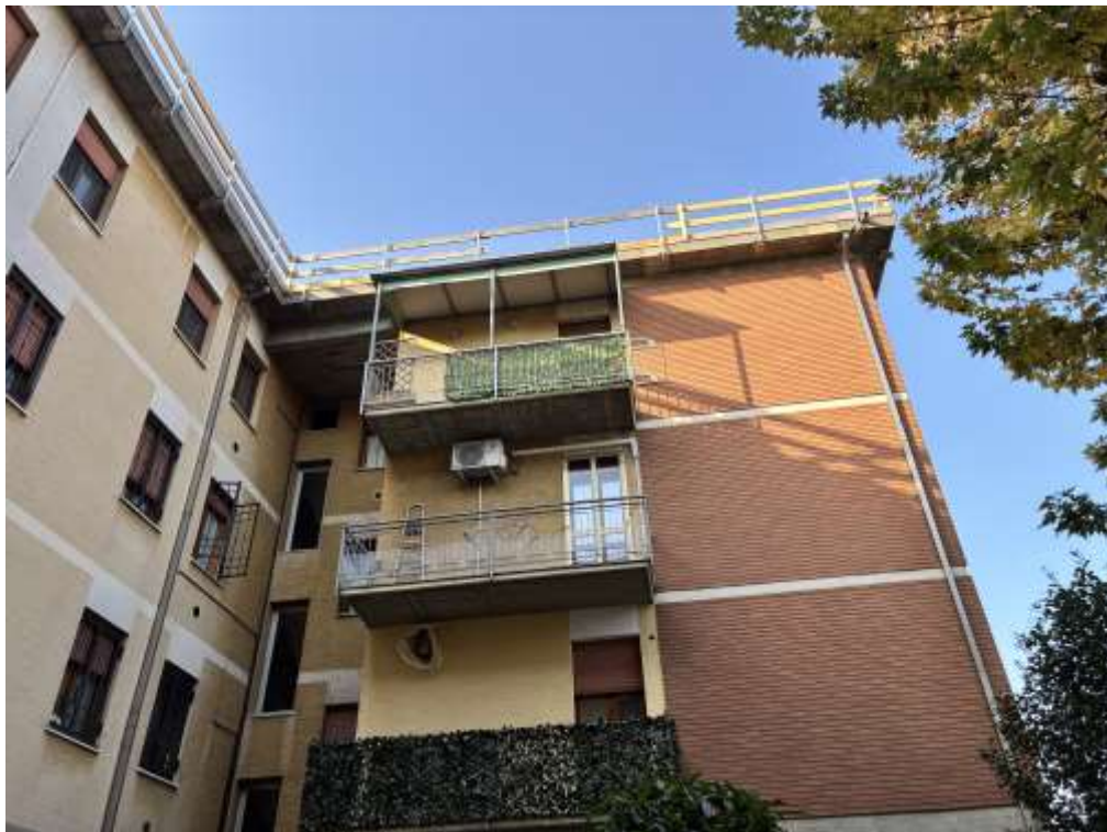
Vista esterna lato nord/ovest
