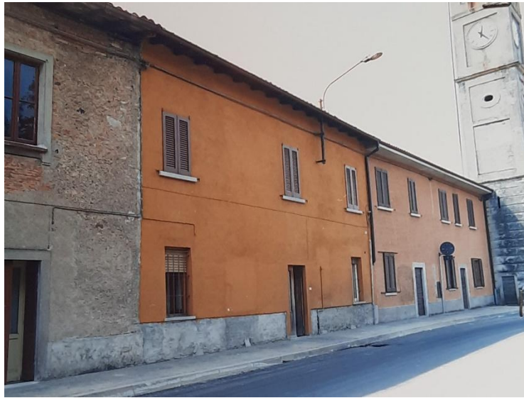
FOTO 1 – VISTA DELL'ABITAZIONE DALLA STRADA
