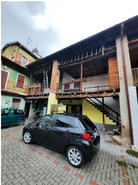
FOTO 2 – VISTA ESTERNO DAL CORTILE
