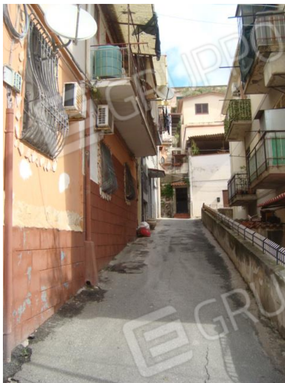
Foto n. 3 – Prospetto e ingresso dalla via 41C
