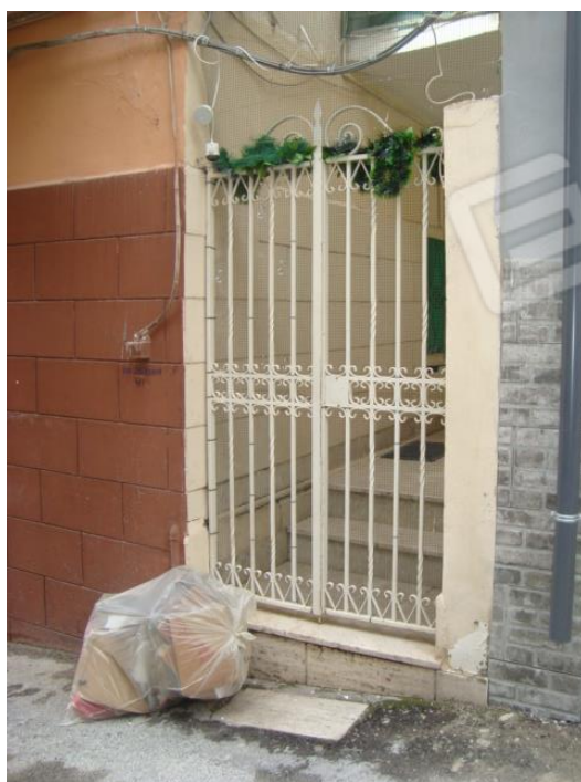
Foto n. 4 – Prospetto e ingresso dalla via 41C
