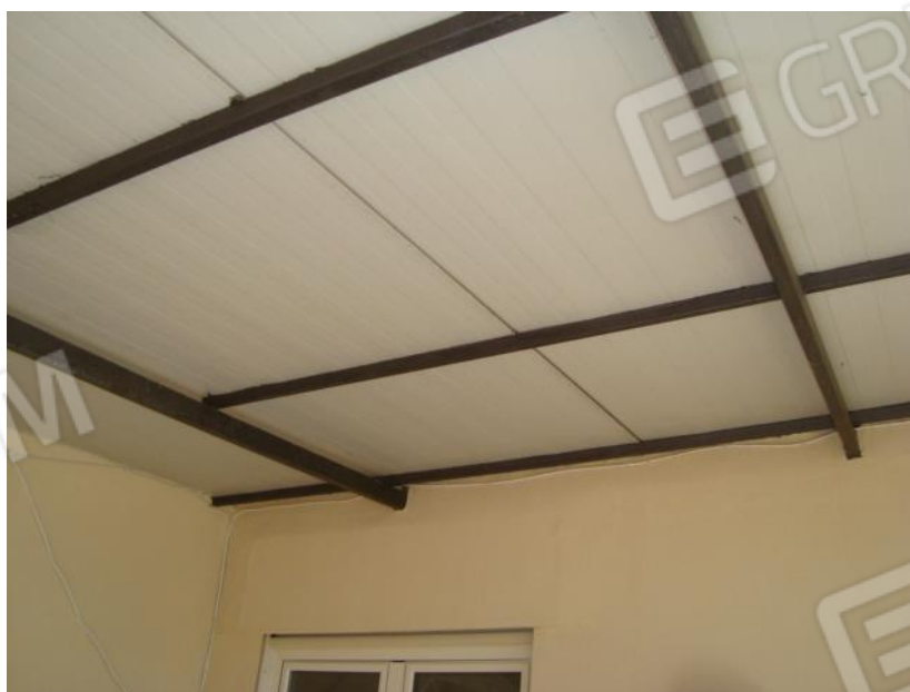
Foto n. 16 – Particola della copertura del terrazzo
