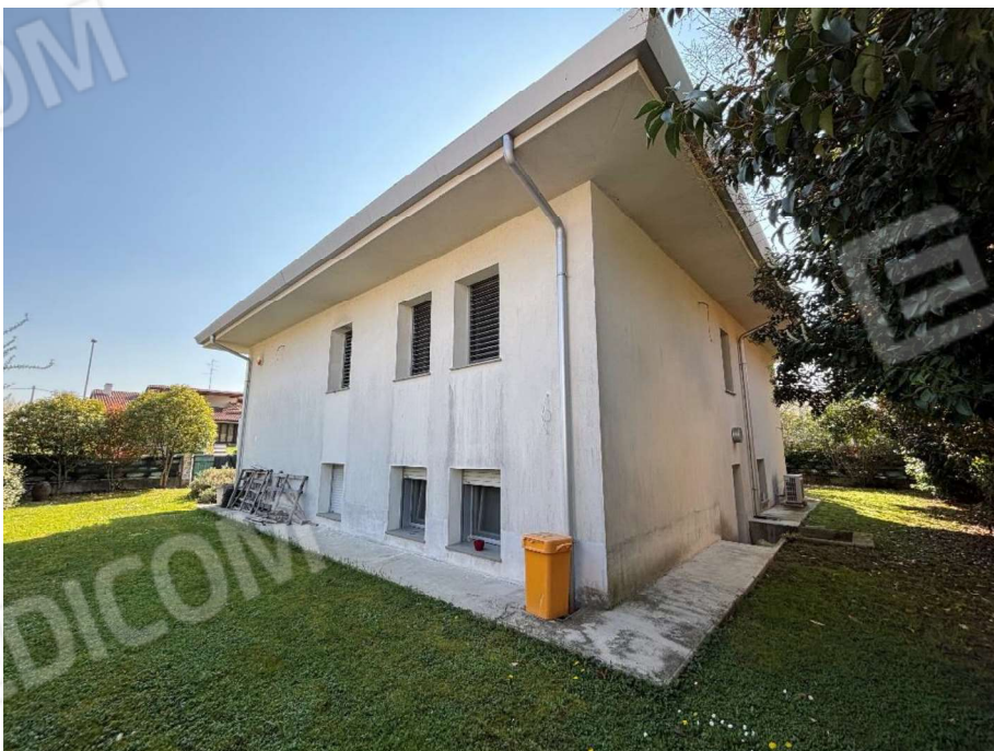
Vista esterna laterale da interno proprietà
