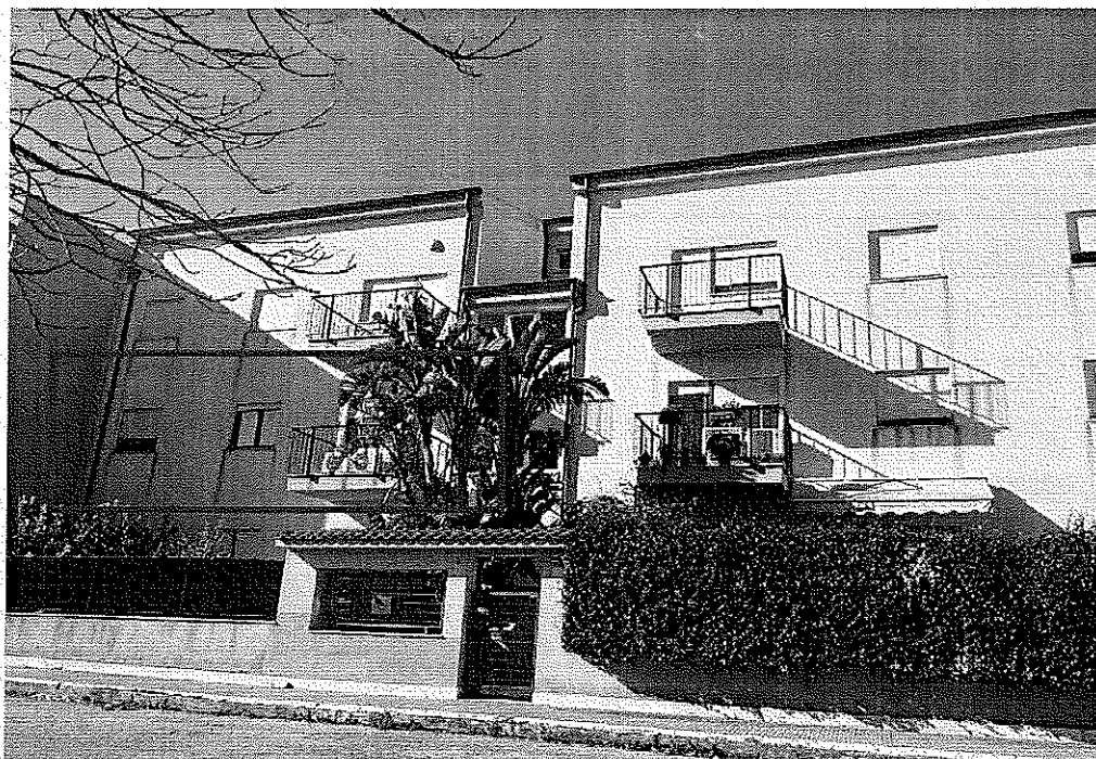
IMMAGINE 4 – PORZIONE PROSPETTO VIA G. GIARDINA
