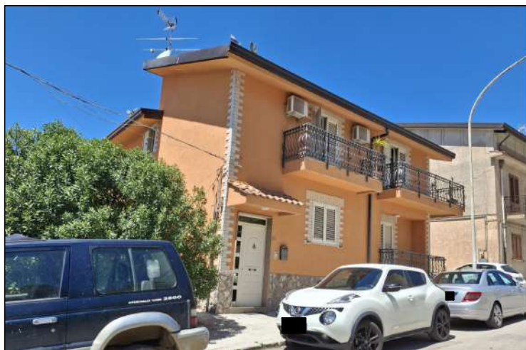
prospetto principale su via Armando Diaz
