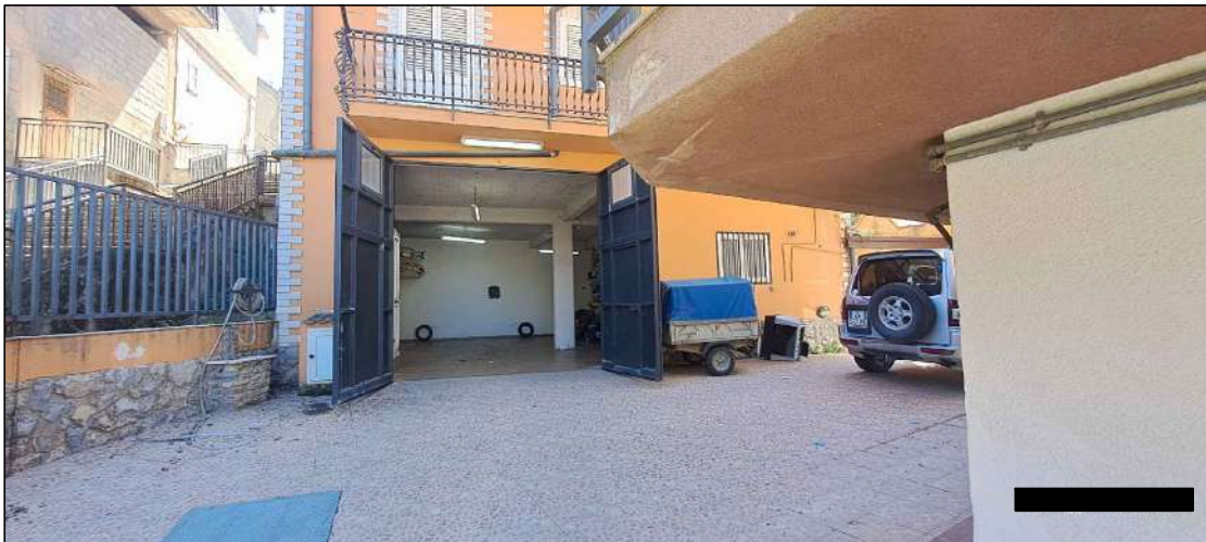
vista esterno locale sgombero - piano sottostrada S2
