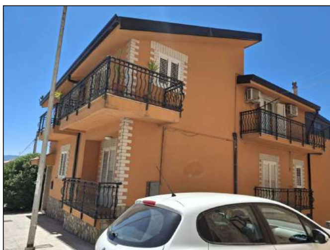
prospetto principale su via Armando Diaz
