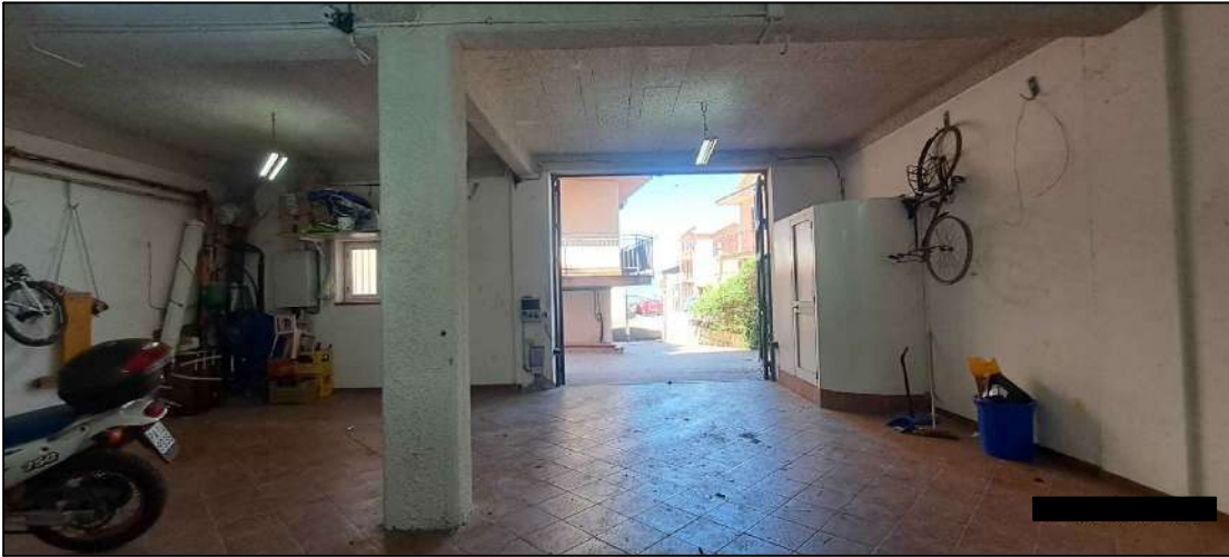
locale sgombero - piano sottostrada S2
