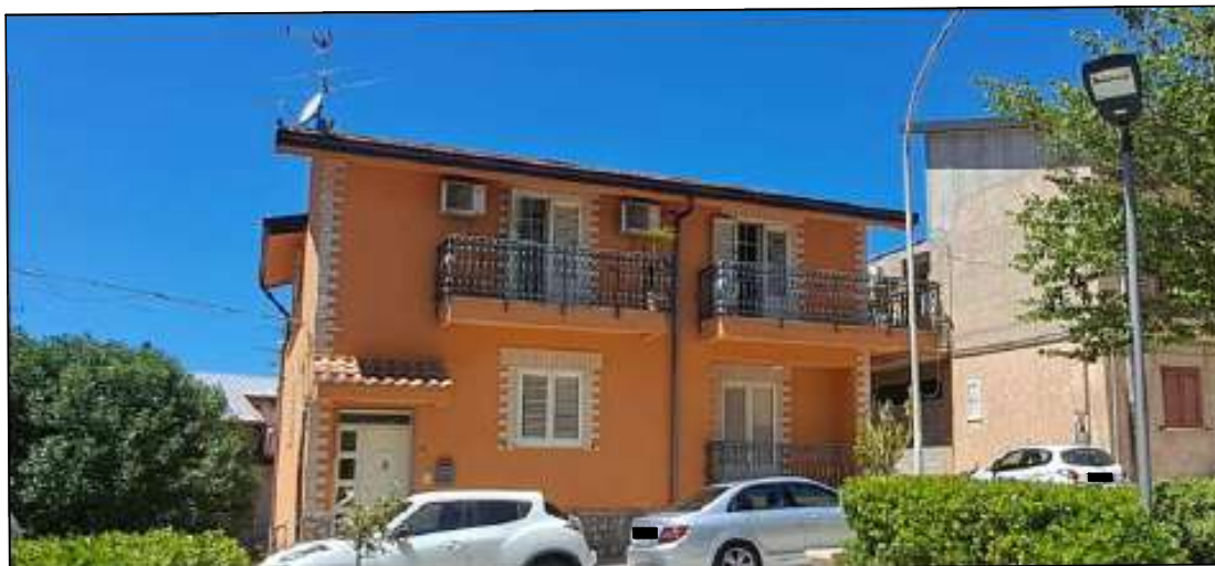
prospetto principale su via Armando Diaz
