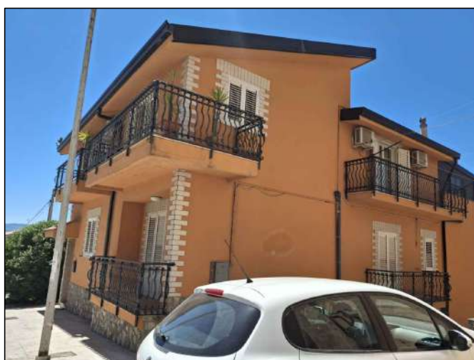
prospetto principale su via Armando Diaz
