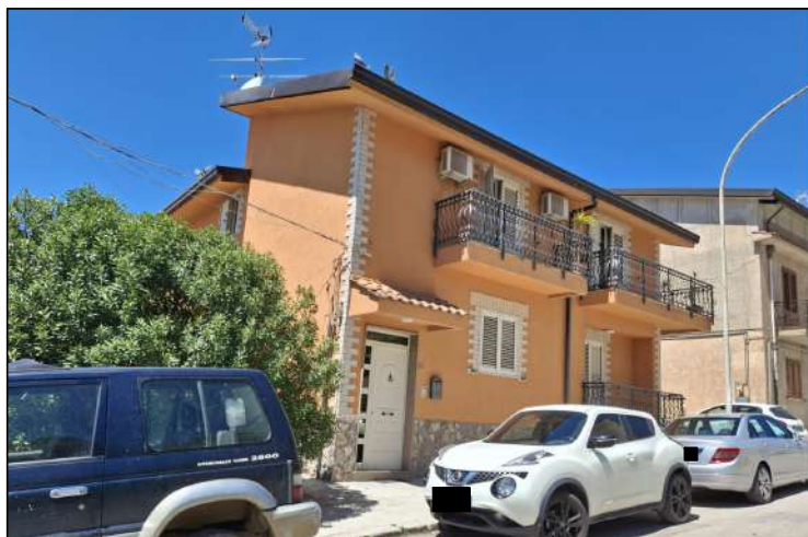
prospetto principale su via Armando Diaz
