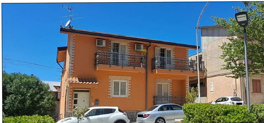
prospetto principale su via Armando Diaz
