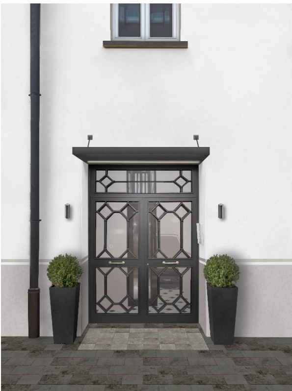
Portone d'ingresso edificio dal cortile
