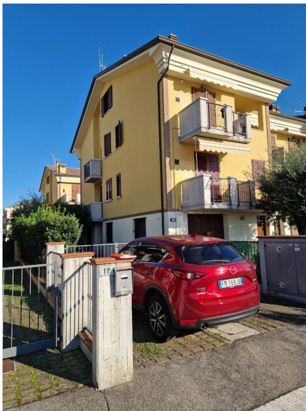
FOTO – prospetto dalla Via Eugenio Montale
