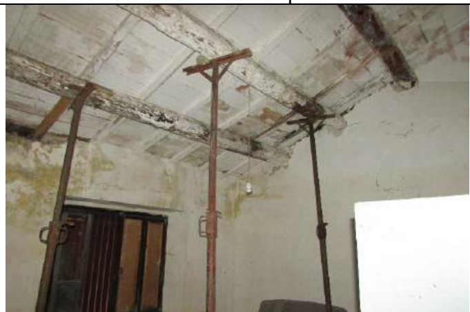
Foto 3 – Interno Lotto 1 - Corpo 1 Casa Rurale -
