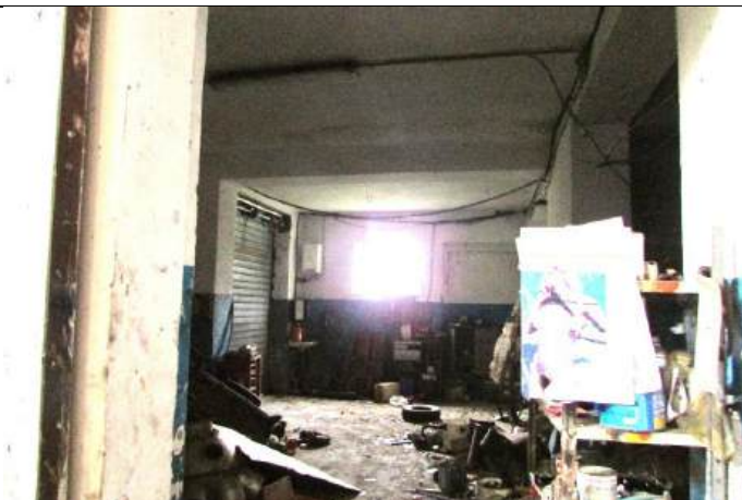
Foto 1 – Interno Lotto 1 - Corpo 1 Casa Rurale -
