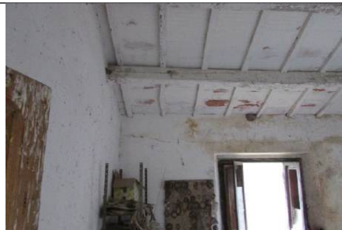
Foto 2 – Interno Lotto 1 - Corpo 1 Casa Rurale -
