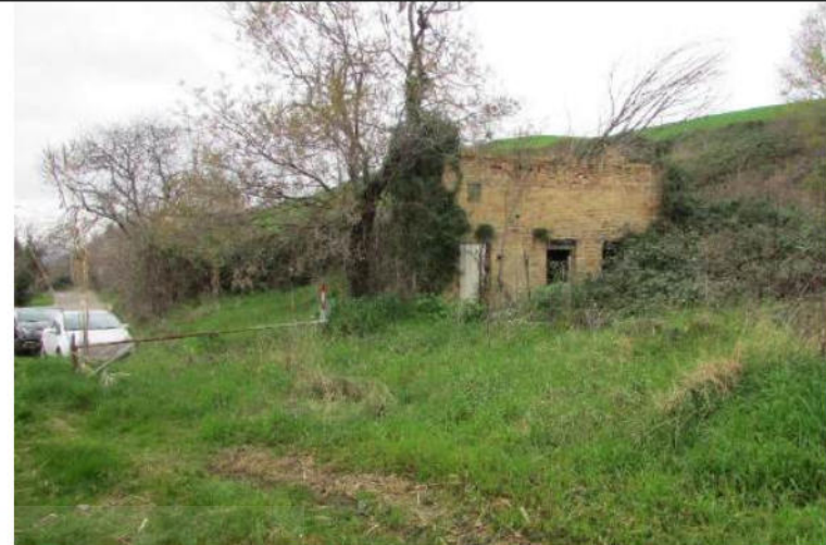
Foto 2 - Lotto 1 - Corpo 4 Annesso -
