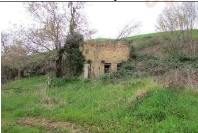
Foto 3 - Lotto 1 - Corpo 4 Annesso -
