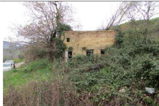
Foto 4 - Lotto 1 - Corpo 4 Annesso -
