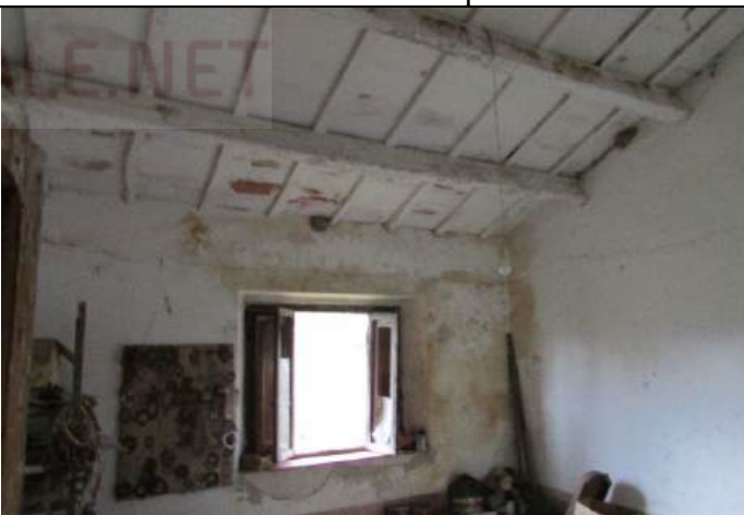
Foto 4 – Interno Lotto 1 - Corpo 1 Casa Rurale -
